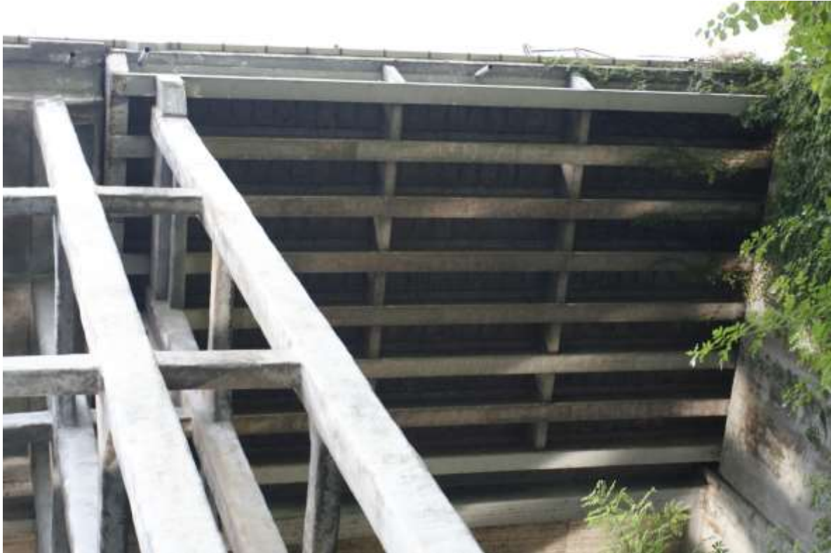
Dettaglio delle nuove travi che sostituiscono i vecchi impalcati con travi tralicciate in cls
