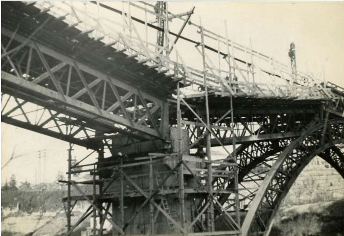
Dettaglio dei nasi in cls lasciati sulle pile per appoggiarvi le strutture tagliate ed abbassate
