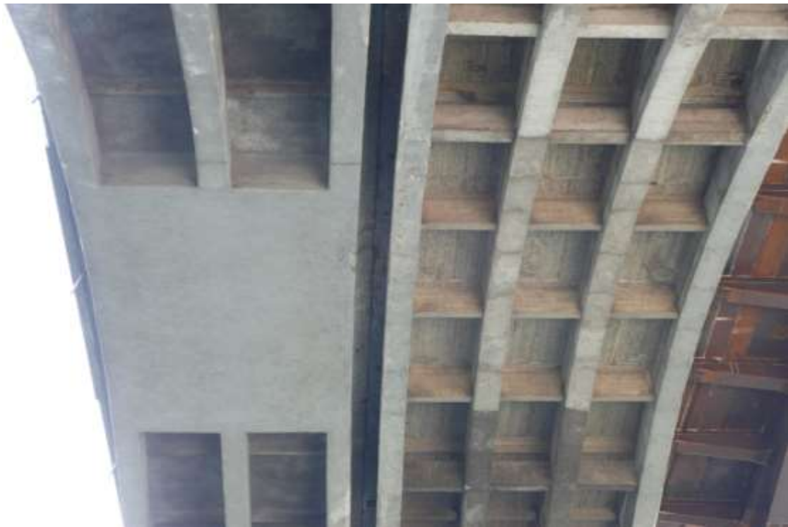
Accoppiamento ponti anni 30 e 50 con vista da sotto chiave arco Ponte autostradale in cls realizzato negli anni 50
