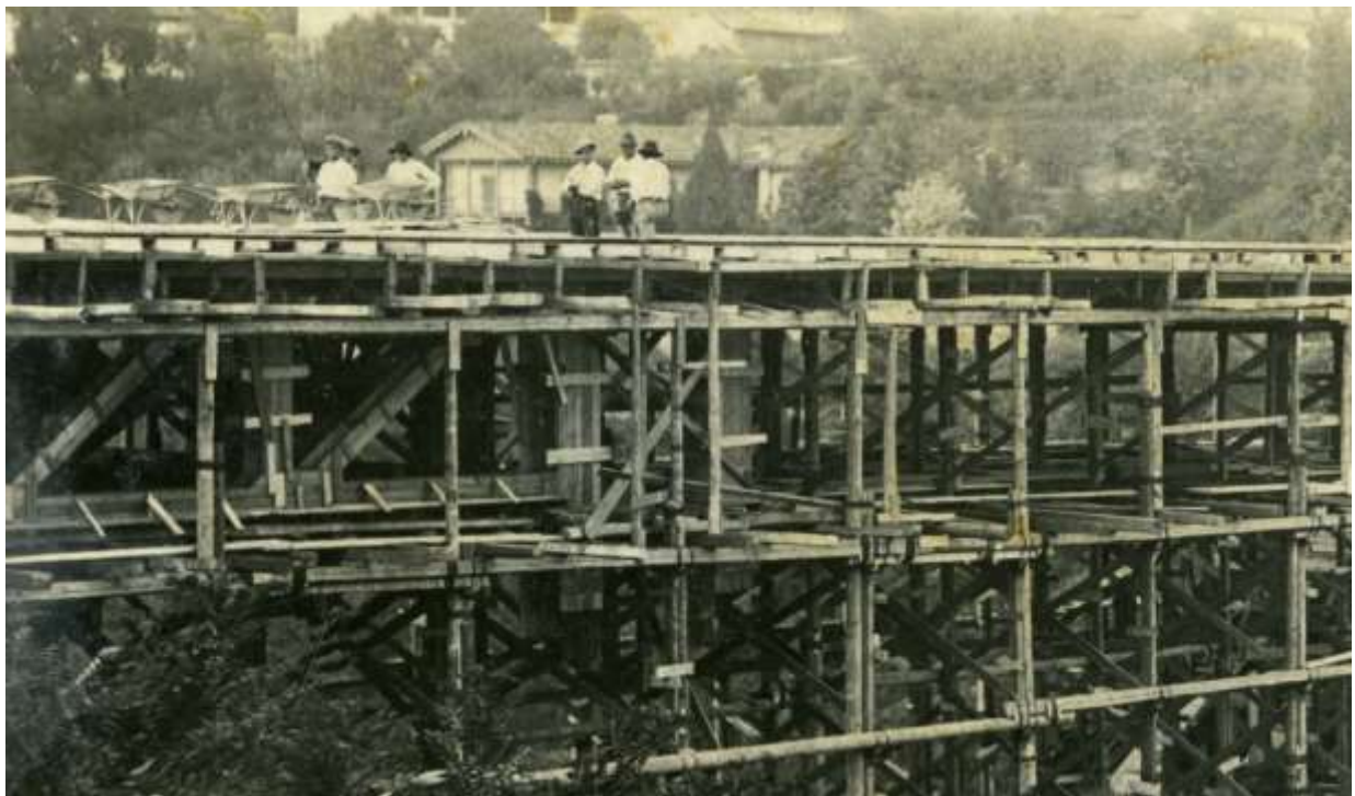
dettaglio del cassero per le travi tralicciate delle campate di accesso
