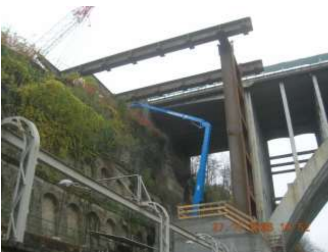
Montaggio pile e traversi campate di appoggio zona arco
