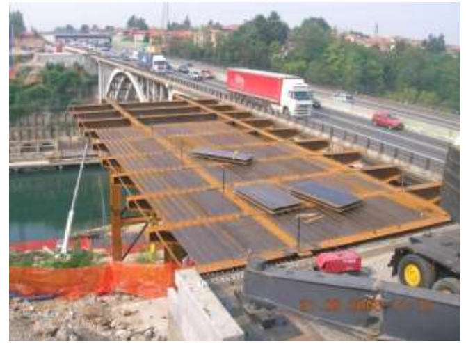
Montaggio traversi a sbalzo e montaggio delle predalles
