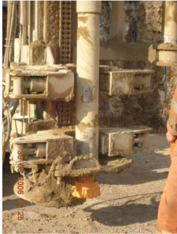
Realizzazione di micropali sotto le fondazioni
