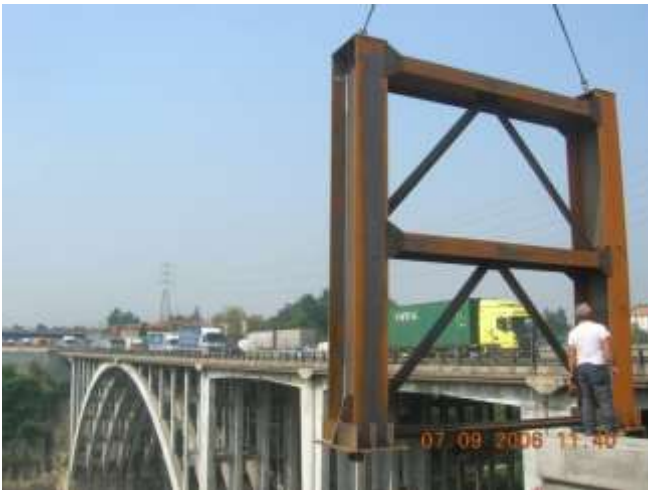
Montaggio pile e travi longitudinali
