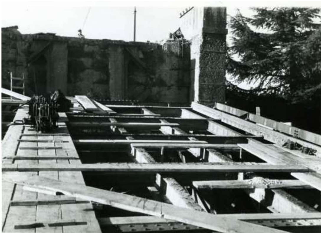
Dettagli delle cassature in legno che appoggiano sulle strutture in ferro già abbassate
