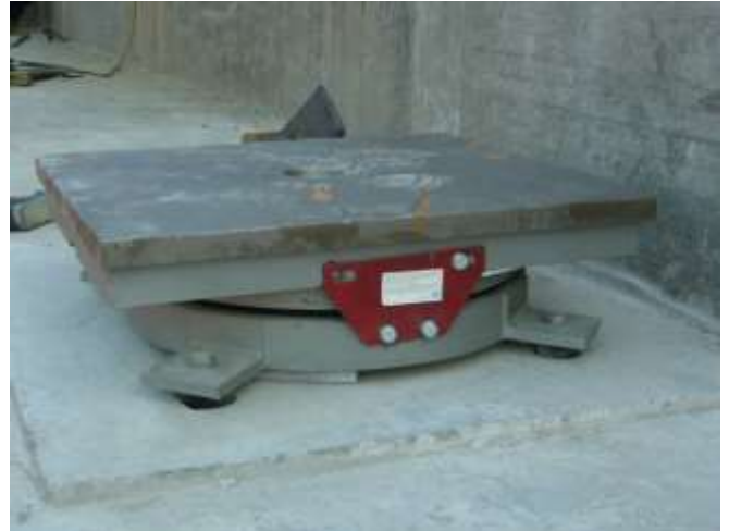
Completamento spalla la Bergamo e posa appoggi
