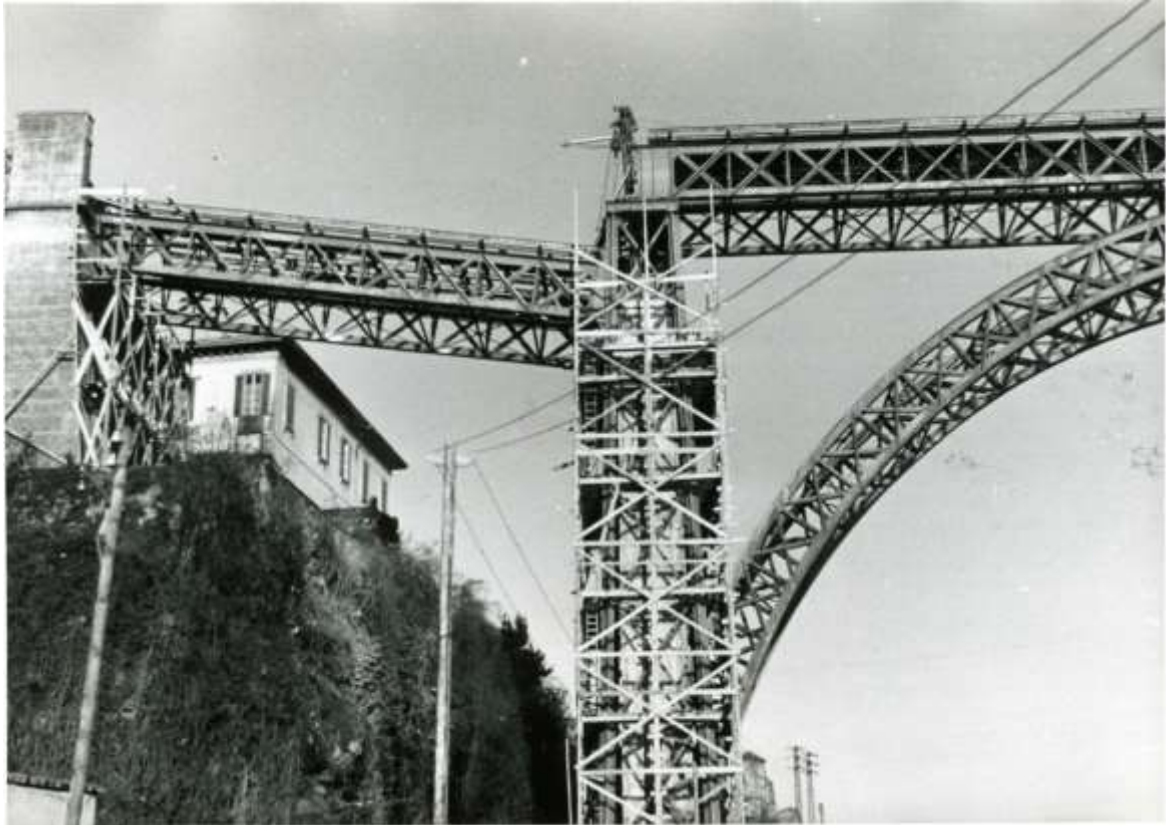
Sistema di argani per abbassare le vecchie strutture in ferro e le pile in cls. già completate
