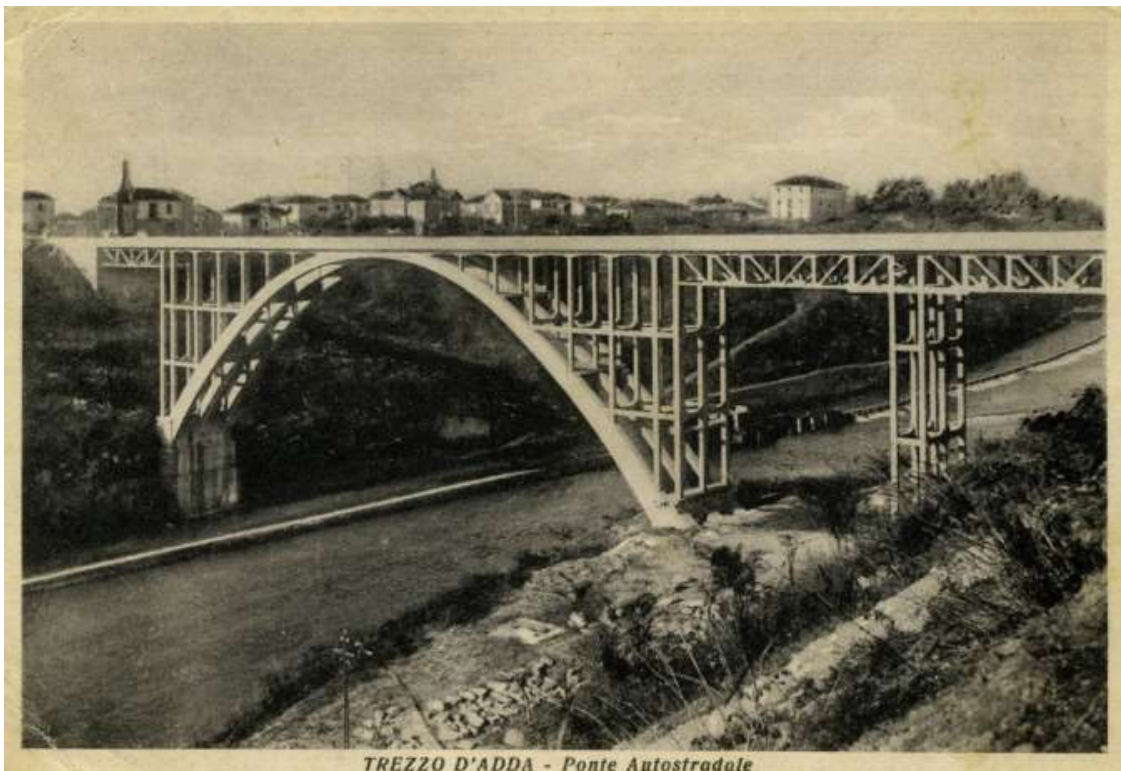
TREZZO D'ADDA - Ponte Autostradale
