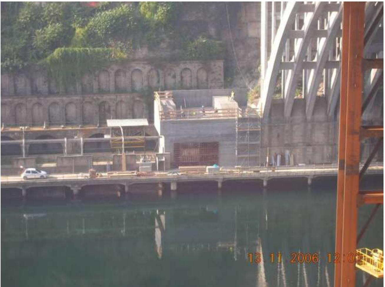
Completamento fondazione arco lato Milano – Vista panoramica
