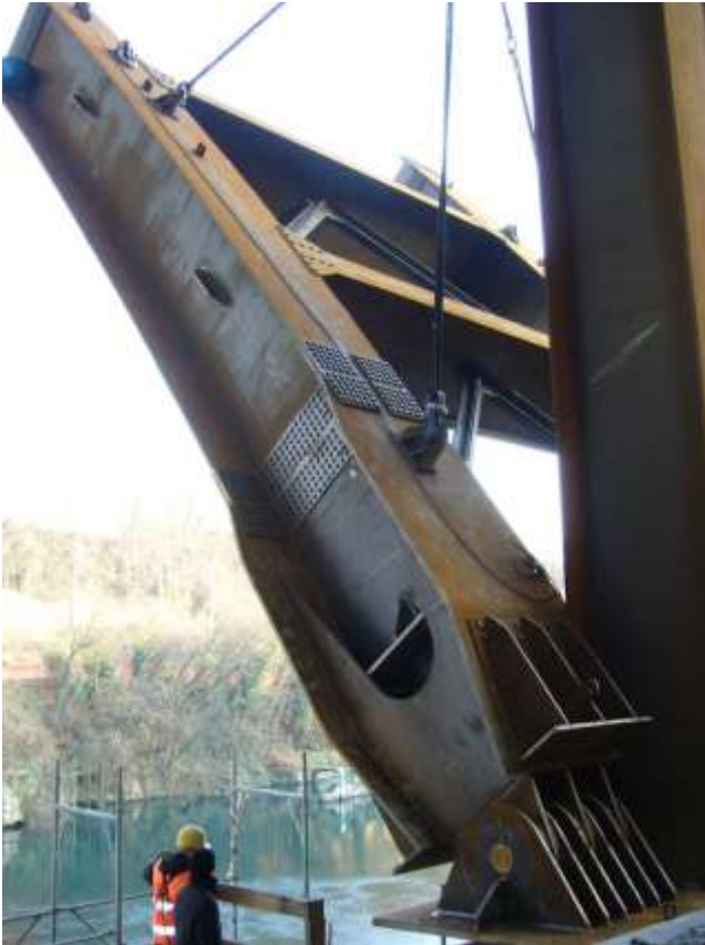
Montaggio parte di arco inferiore lato Bergamo e secondo elemento lato Milano
