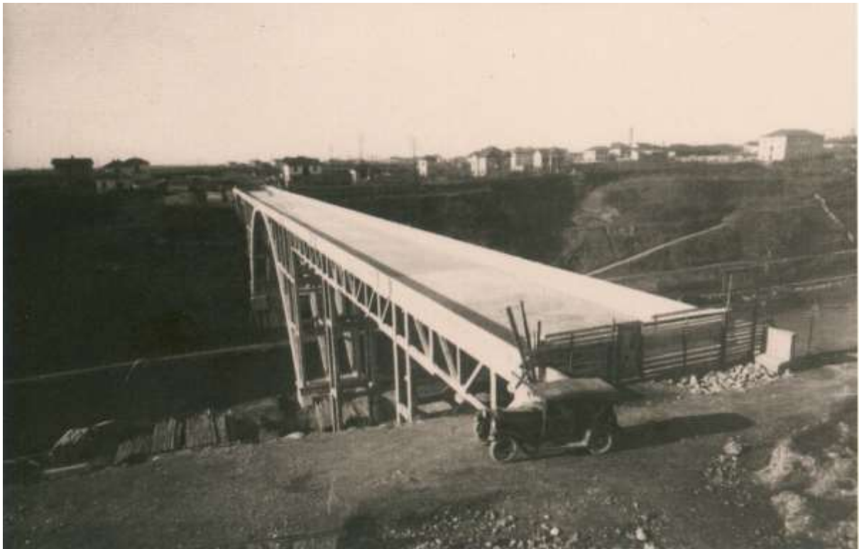
il ponte completato, non ancora aperto al traffico
