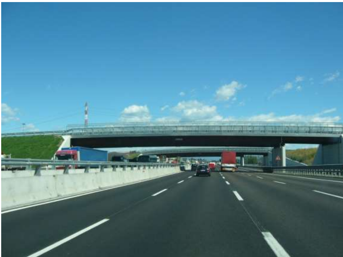
Barriera di sicurezza centrale in corrispondenza di opere d'arte
