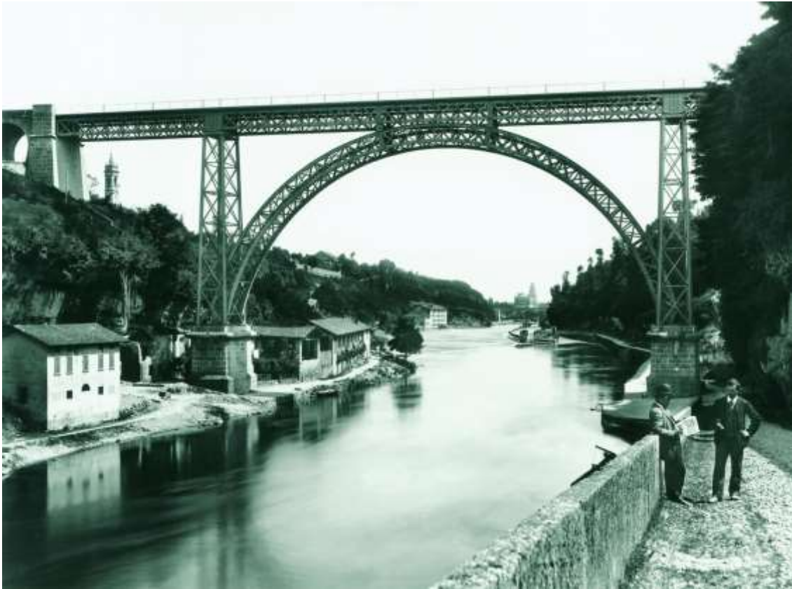
Ponte finito visto da Nord e le strutture in ferro del vecchio ponte tagliate ed abbassate
