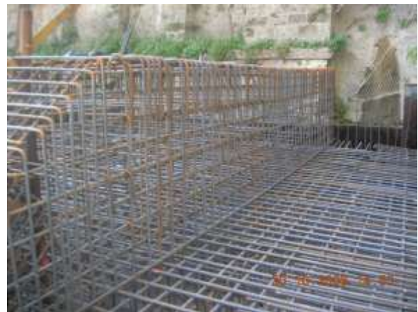
Armatura in ferro di alcune fondazioni
