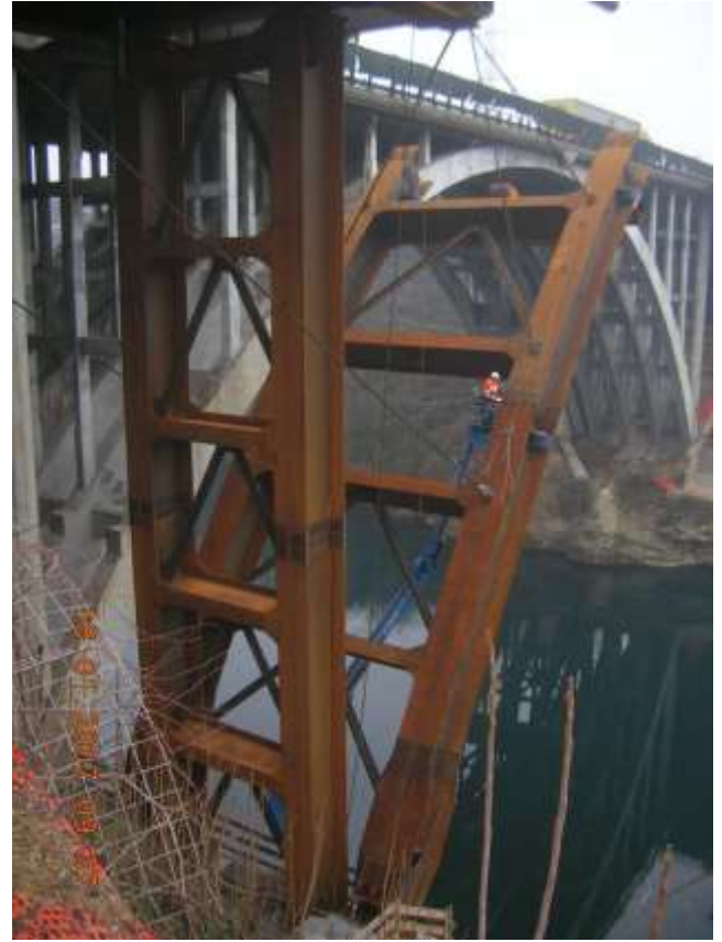
Montaggio parte di arco inferiore lato Bergamo e secondo elemento lato Milano
