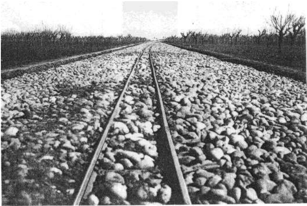
Compiuto il lavoro di sterro vien deposto il fondo di ghiaia.
