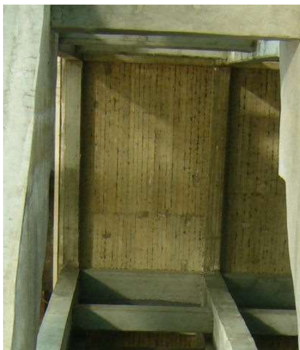
campo di soletta in calcestruzzo gettato in opera all'interno della campata delle arcate
