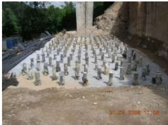
Realizzazione di micropali sotto le fondazioni
