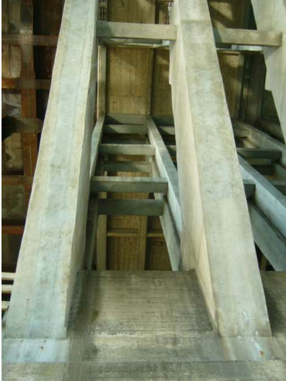
Dettaglio ponte anni 60 – attacco arco, pile, traversi, impalcato – solette e irrigidimenti
