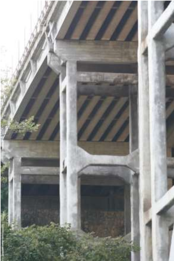
Campate di accesso lato Bergamo rifatte con travi prefabbricate. Dettaglio nuovo traverso su cui appoggiano le travi prefabbricate. Moncherino aggiunto a sbalzo dalle colonne delle pile per appoggiare travi di bordo.
