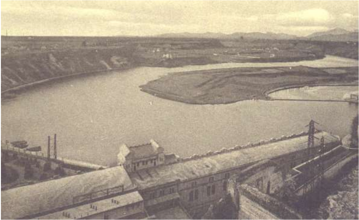
Centrale vista dall'alto con a destra la briglia costruita nel fiume per alzare il pelo dell'acqua
