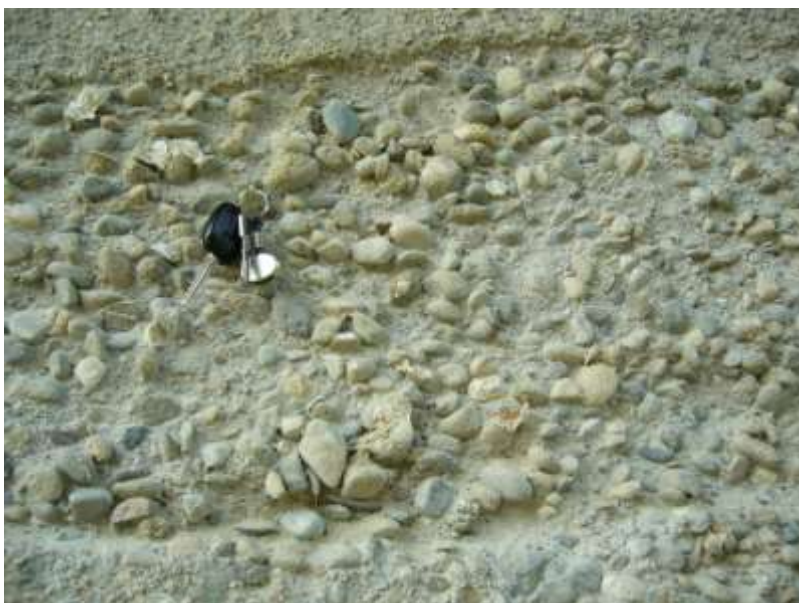
aspetto esterno delle superfici dei getti di calcestruzzo in evidenza gli inerti di origine alluvionale
