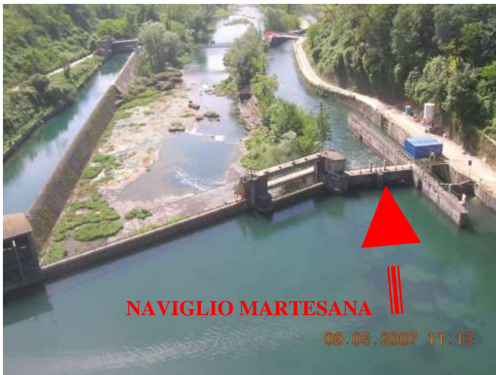
Vista del sistema di regolazione a valle delle prese della centrale Italcementi. Da sinistra: la presa per la centrale Bertini – La paratoia di regolazione principale, paratoia automatica, Presa canale Naviglio Martesana, bocca a bacino per immissione natante.
