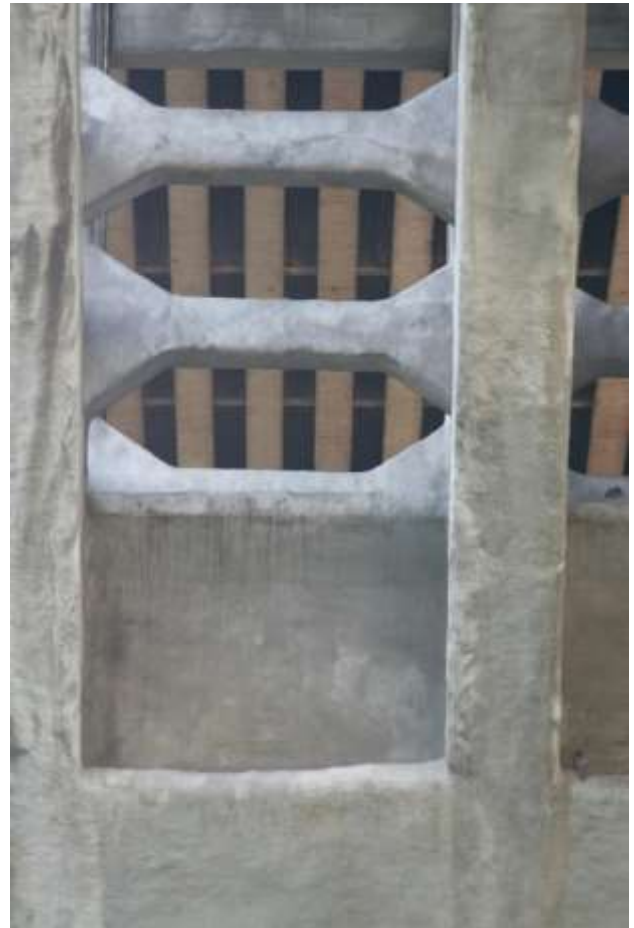
Dettagli ponte anno 27 e trattamento di risanamento
