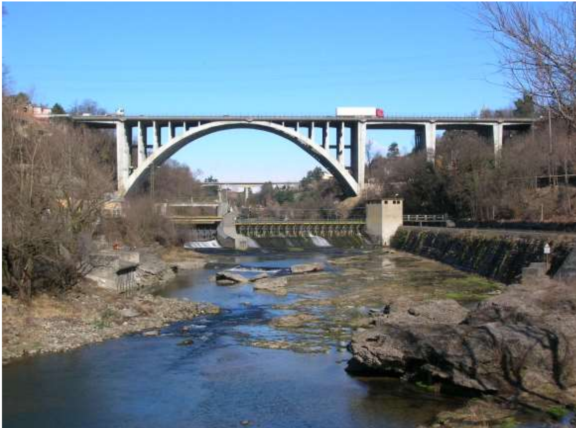
vista di assieme dei due manufatti 1927 e 1966, eseguita nel 2006 nel ponte 1927 sono state sostituite le campate di approccio reticolari con travi a parete piena
