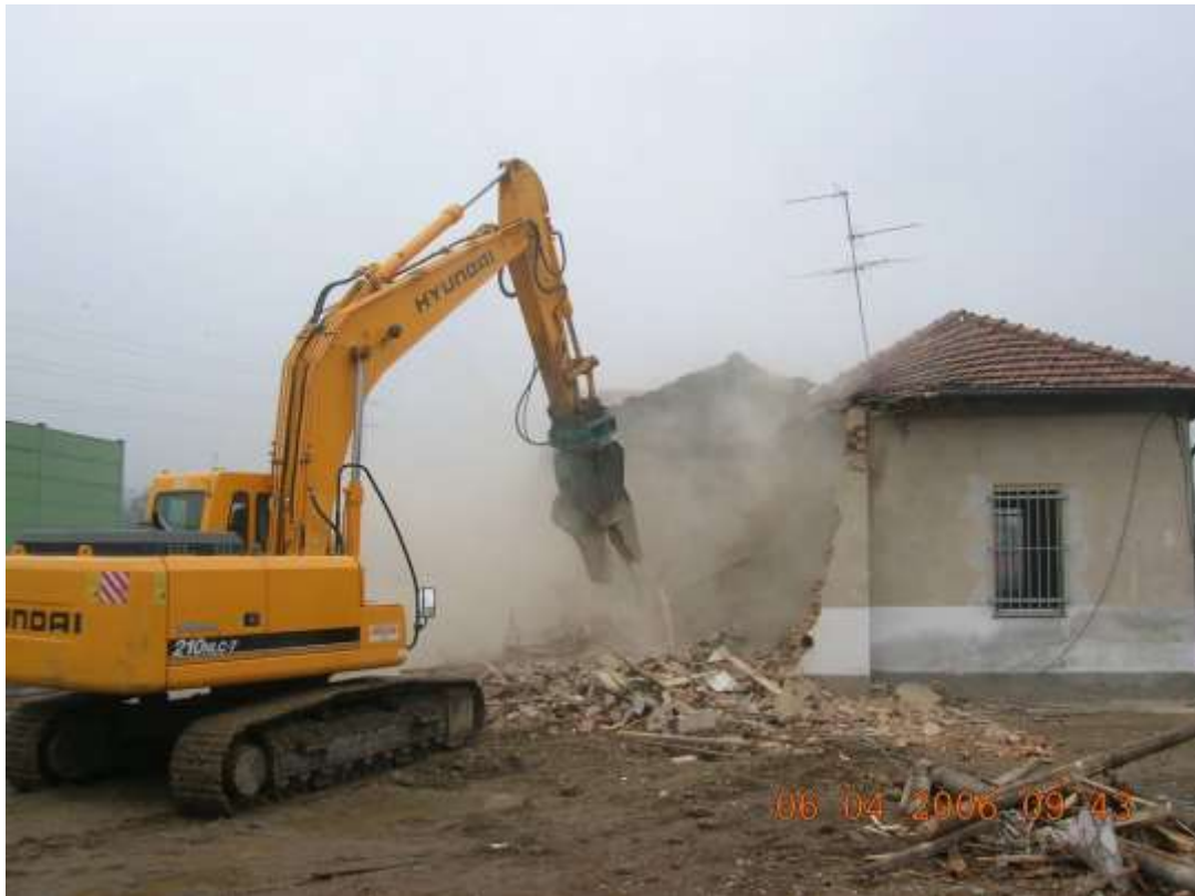
Demolizione edifici sul nuovo tracciato del 3° ponte
