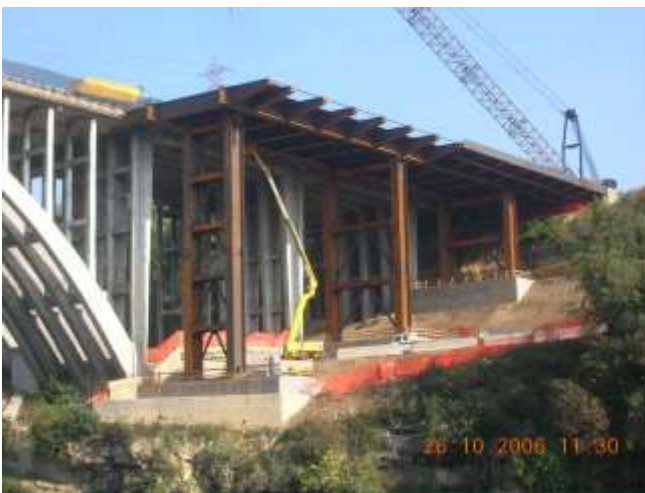
Vista d'insieme struttura montata delle campate di accesso zona arco lato Bergamo
