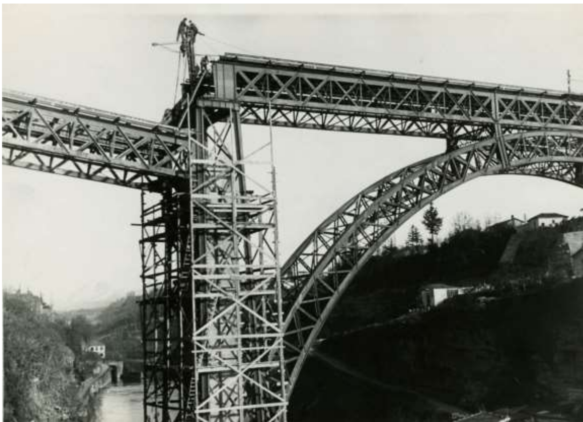
Sistema di argani per abbassare le vecchie strutture in ferro e le pile in cls. già completate
