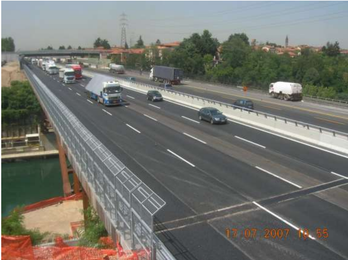
Nuovo ponte sul fiume Adda con 4 Corsie più l'emergenza in entrambe le direzioni di marcia
