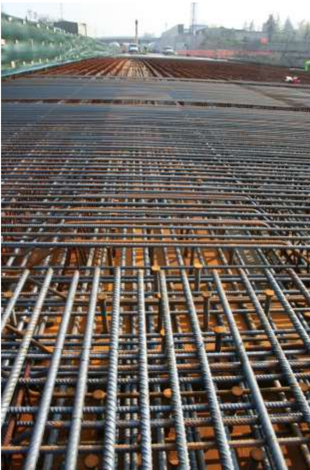
Posa ferro e getto per fasi della rimanente parte di campata
