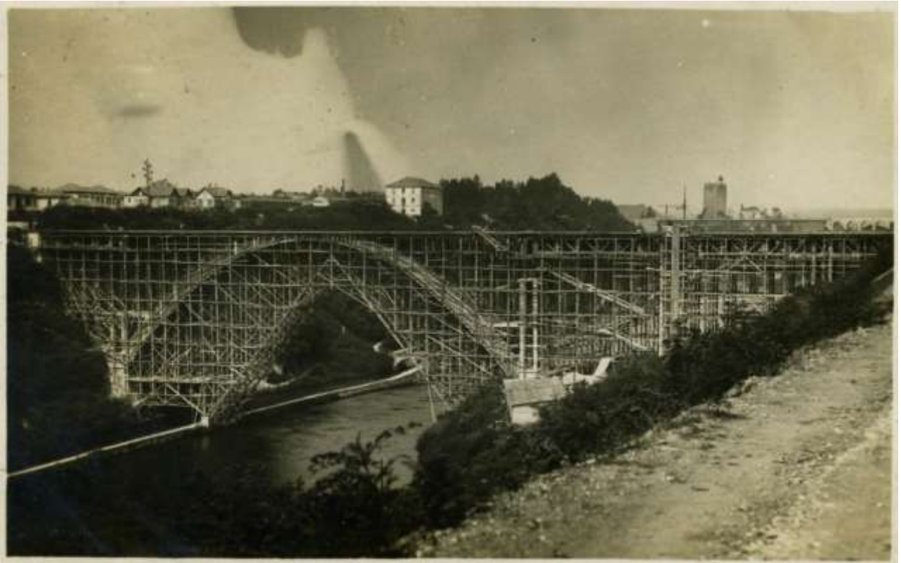
completamento dei casseri degli archi e delle pile
