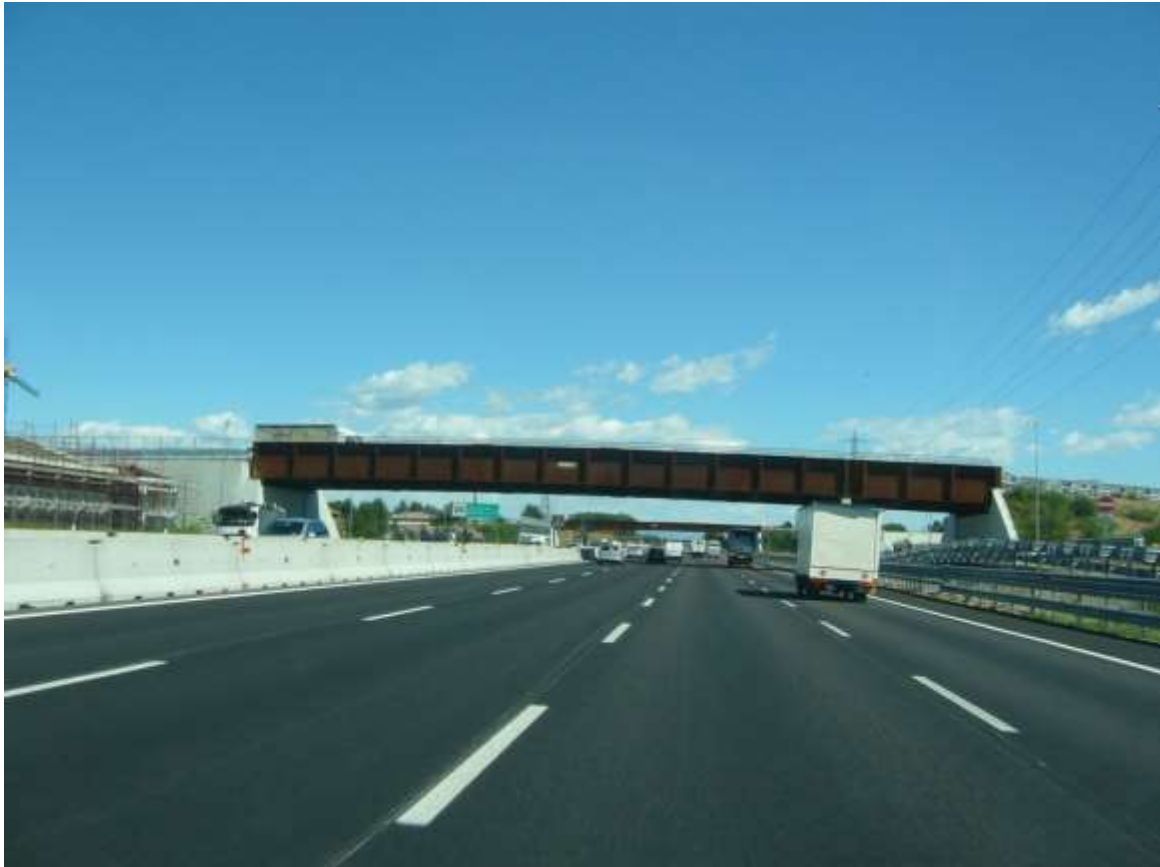
Nuova generazione di cavalcavia con luci fino a 60 metri ed altezza libera di mt. 5,50
