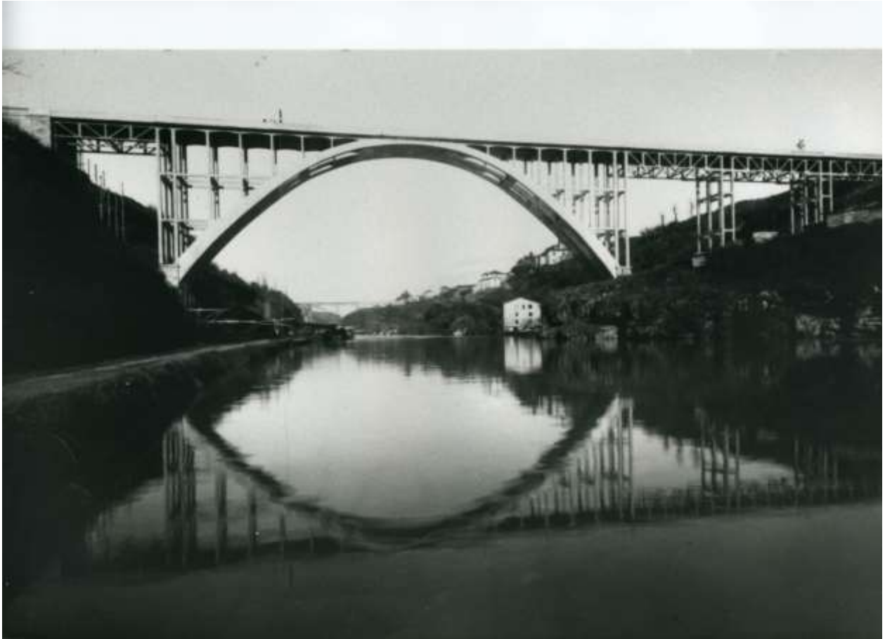
l'elegante linea del ponte vista da valle
