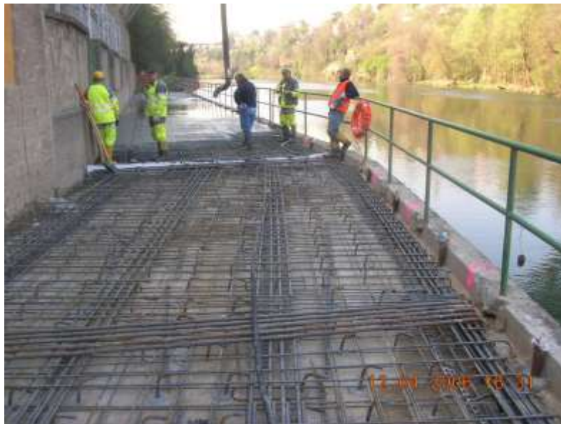
Rinforzo soletta attraversamento bocche di presa centrale idroelettrica Italcementi
