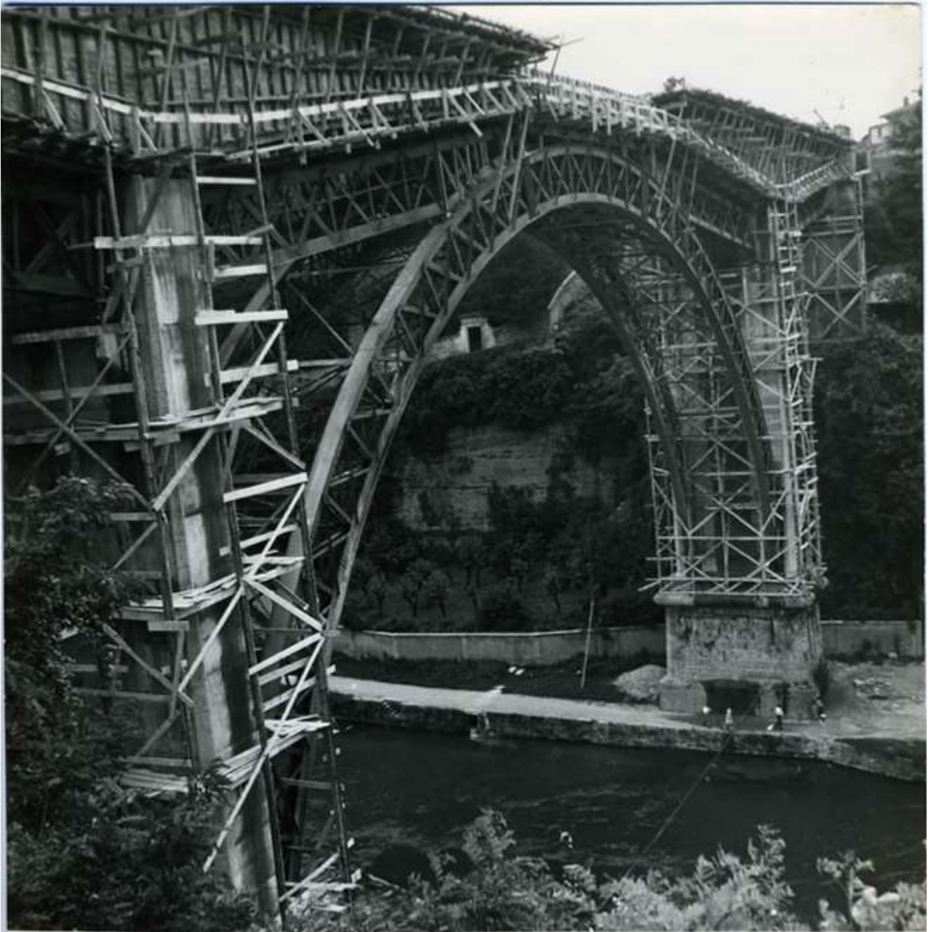
Dettaglio di tutto il sistema predisposto dall'Impresa Ferrobeton per eseguire i lavori
