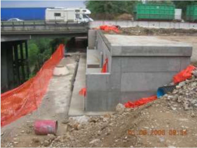
Completamento spalla la Bergamo e posa appoggi
