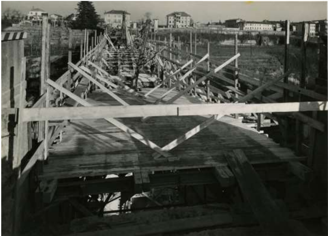
Dettagli delle cassature in legno che appoggiano sulle strutture in ferro già abbassate
