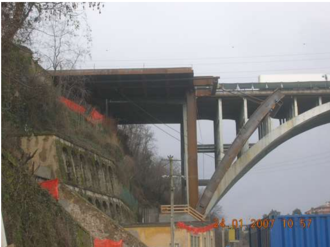
Sostegno dei conci in avanzamento dapprima con 2 stralli provvisori fissi, agganciati all'impalcato, successivamente con un argano che consentisse la regolazione della rotazione
