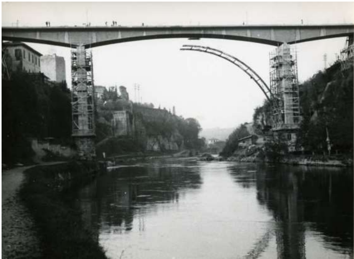
Proseguimento delle fasi di smontaggio. Il ponte di barche è stato già rimosso
