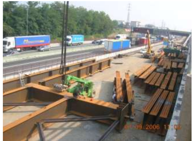
Arrivo e pre assemblaggio componenti struttura
