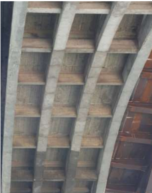
Dettaglio archi dei ponti anno 27 a sinistra e anno 60 a destra
