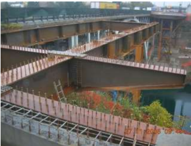
Montaggio traversi a sbalzo e montaggio delle predalles
