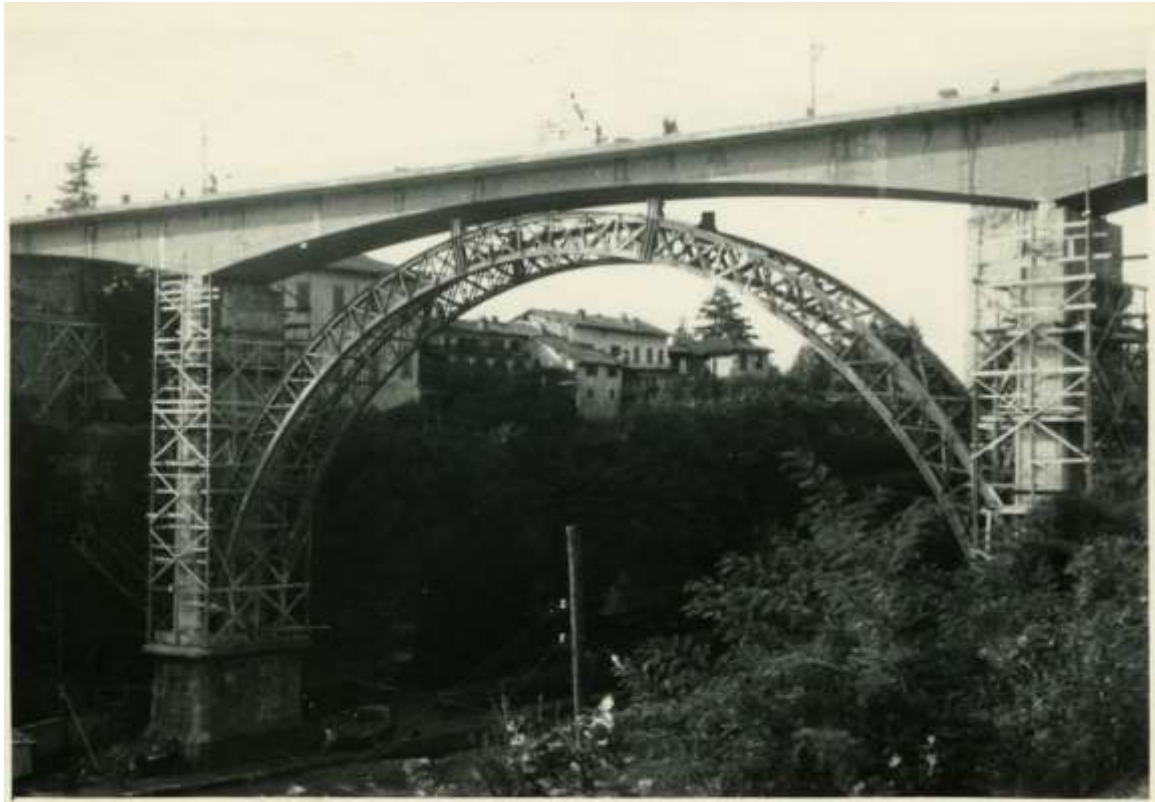
Proseguimento delle fasi di smontaggio. Il ponte di barche è stato già rimosso
