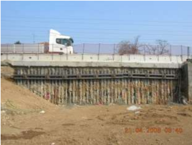
Berlinesi propedeutiche all'isolamento e protezione zone di lavoro
