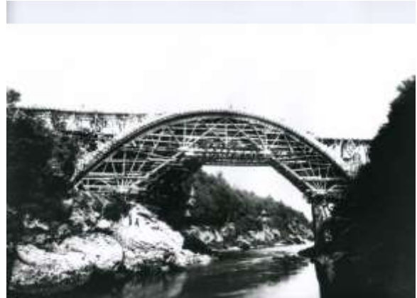
Ponte sul fiume Brembo in costruzione
