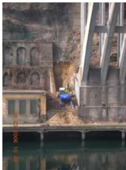
Demolizione edificio Italgas e scavi per la realizzazione delle fondazioni
