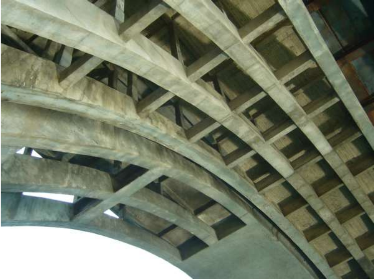
Dettaglio archi dei ponti anno 27 a sinistra e anno 60 a destra
