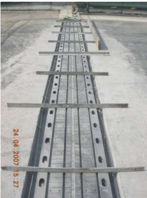
Posa dei giunti e delle barriere bordo ponte
