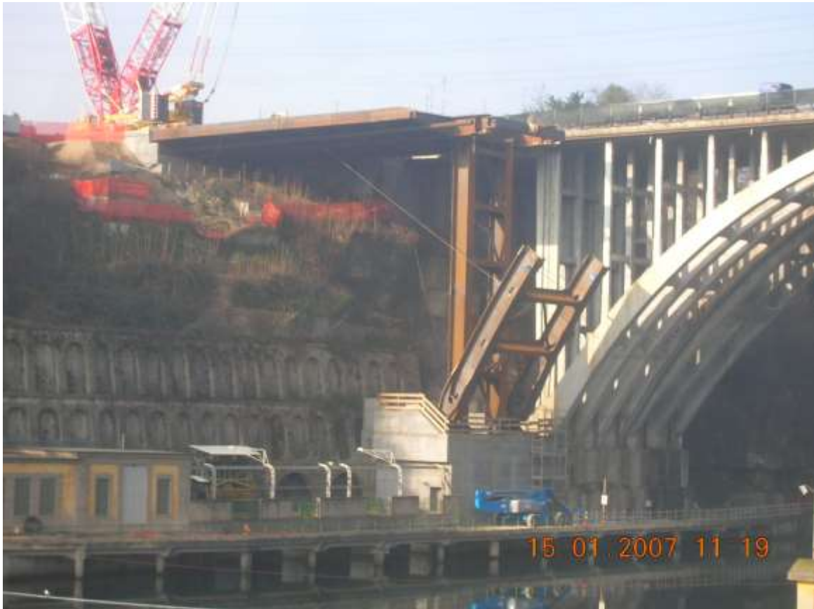
Sostegno dei conci in avanzamento dapprima con 2 stralli provvisori fissi, agganciati all'impalcato, successivamente con un argano che consentisse la regolazione della rotazione
