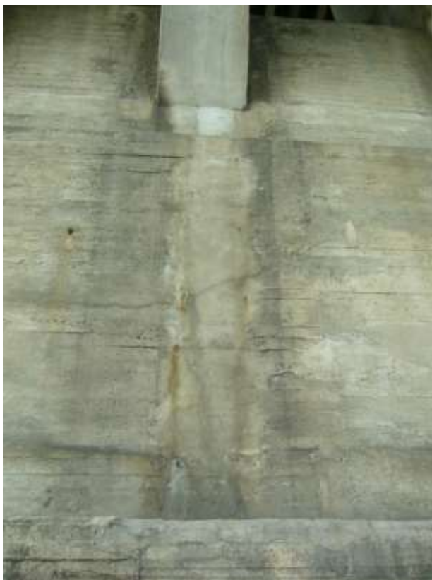
Si noti il taglio degli elementi a bandiera realizzati nell'anno 60 – Vedi foto a ds. Gli elementi a bandiera erano serviti per appoggiare le centine per la realizzazione degli archi
