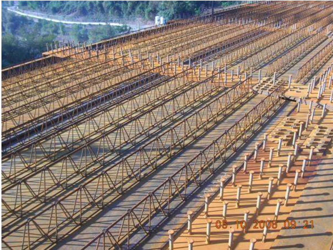
Montaggio delle pile rimanenti che si intestano sull'arco, travi e posa predalles con travi tipo pittini
