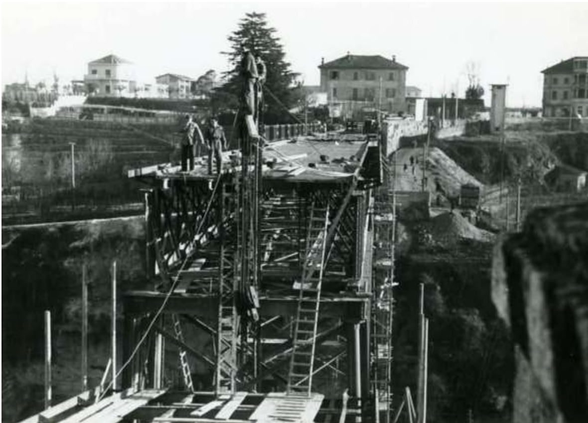
Vista frontale del sistema di argani e carrucole e parte delle vecchie strutture già abbassate
