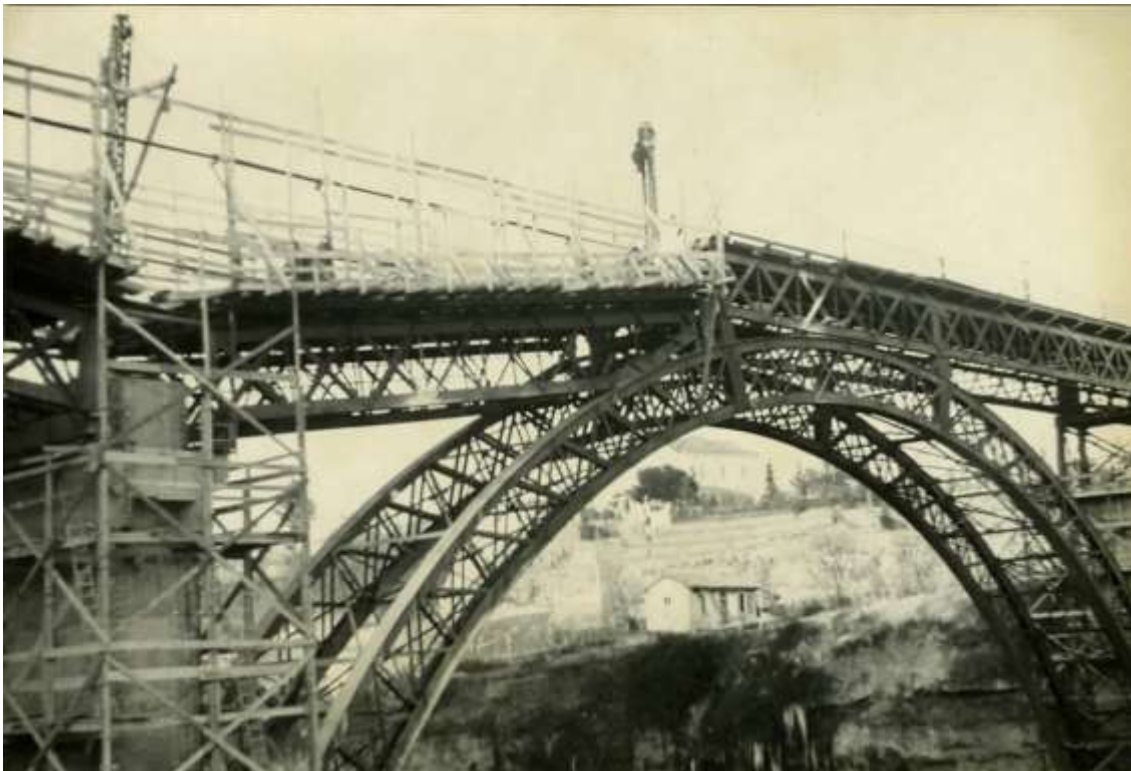
Ponte finito visto da Nord e le strutture in ferro del vecchio ponte tagliate ed abbassate
