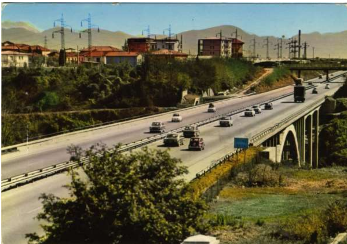
il ponte sul fiume Adda raddoppiato e aperto al traffico negli anni '60, a 2 corsie per senso di marcia
