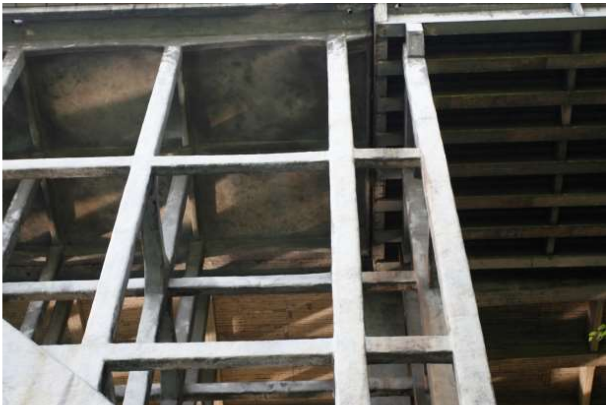
Dettaglio con le campate di accesso modificate e la zona dell'arco rimasta come eseguita nel 27
