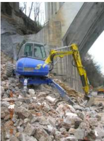
Demolizione edificio Italgas e scavi per la realizzazione delle fondazioni
