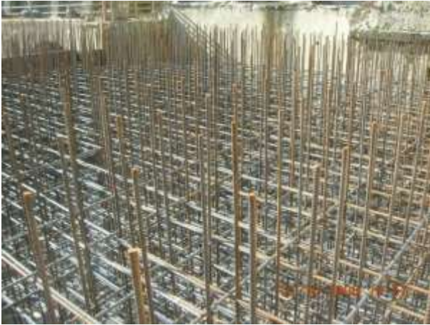
Ferro di rinforzo e posa tirafondi per ancoraggio strutture archi
