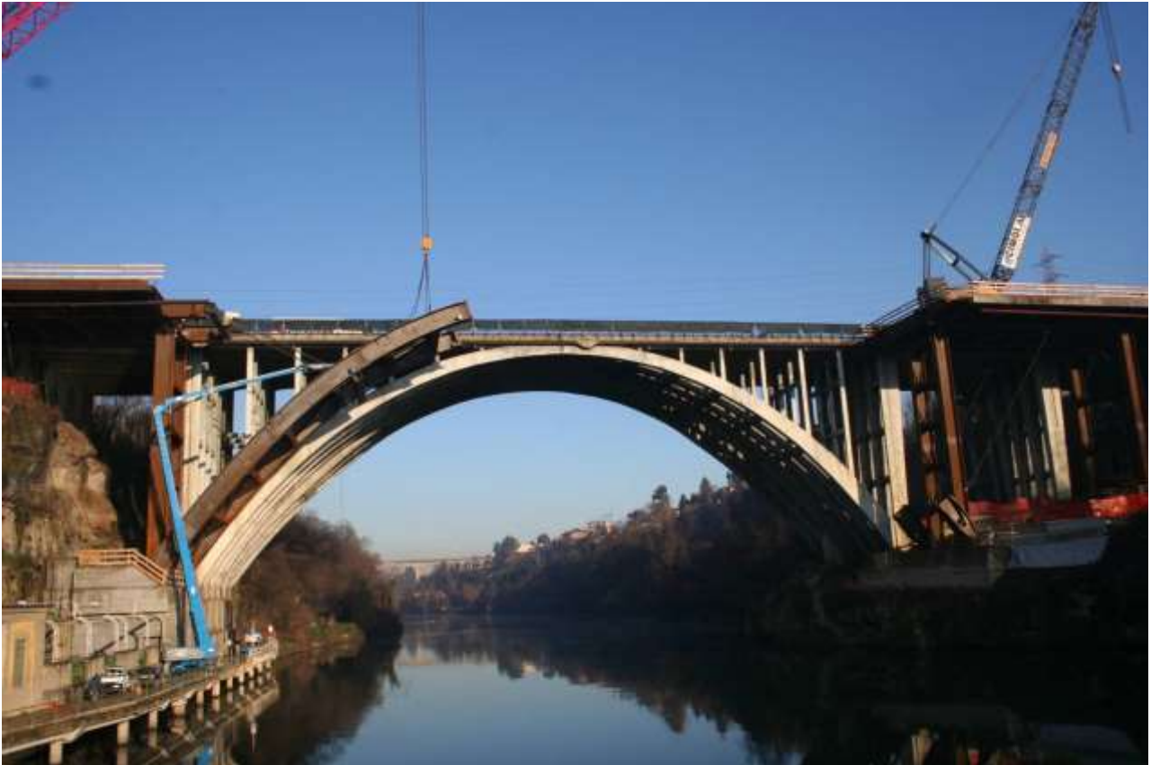
Dettaglio montaggio arco lato Milano. Notasi accesso alle zone di lavoro con piattaforma idraulica
