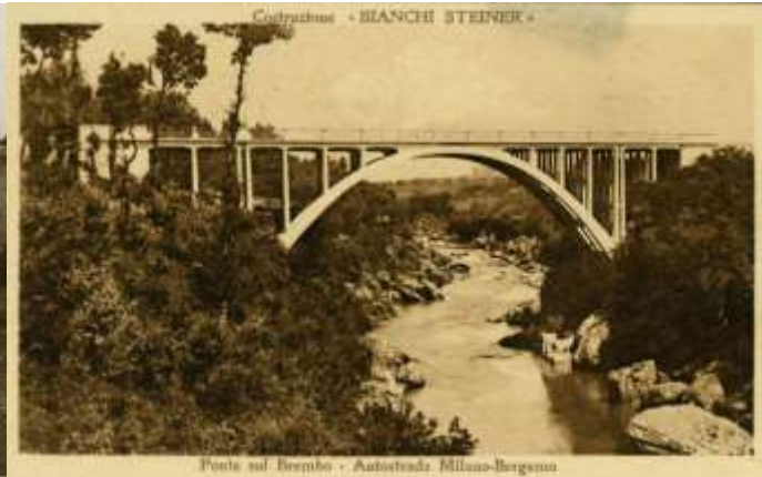
Ponte sul fiume Brembo
