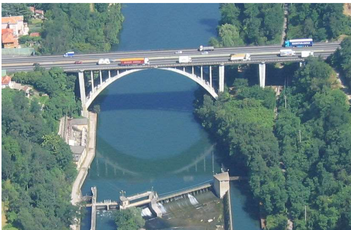
i due ponti degli anni 1927 e 1966 in un'immagine del 2006, con attive le 3 corsie per senso di marcia, prima dell'inizio dei lavori della 4° corsia
