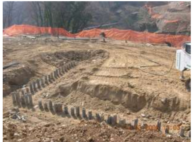
Berlinesi propedeutiche all'isolamento e protezione zone di lavoro
