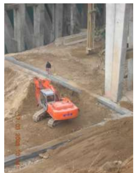
Demolizione edificio Italgas e scavi per la realizzazione delle fondazioni
