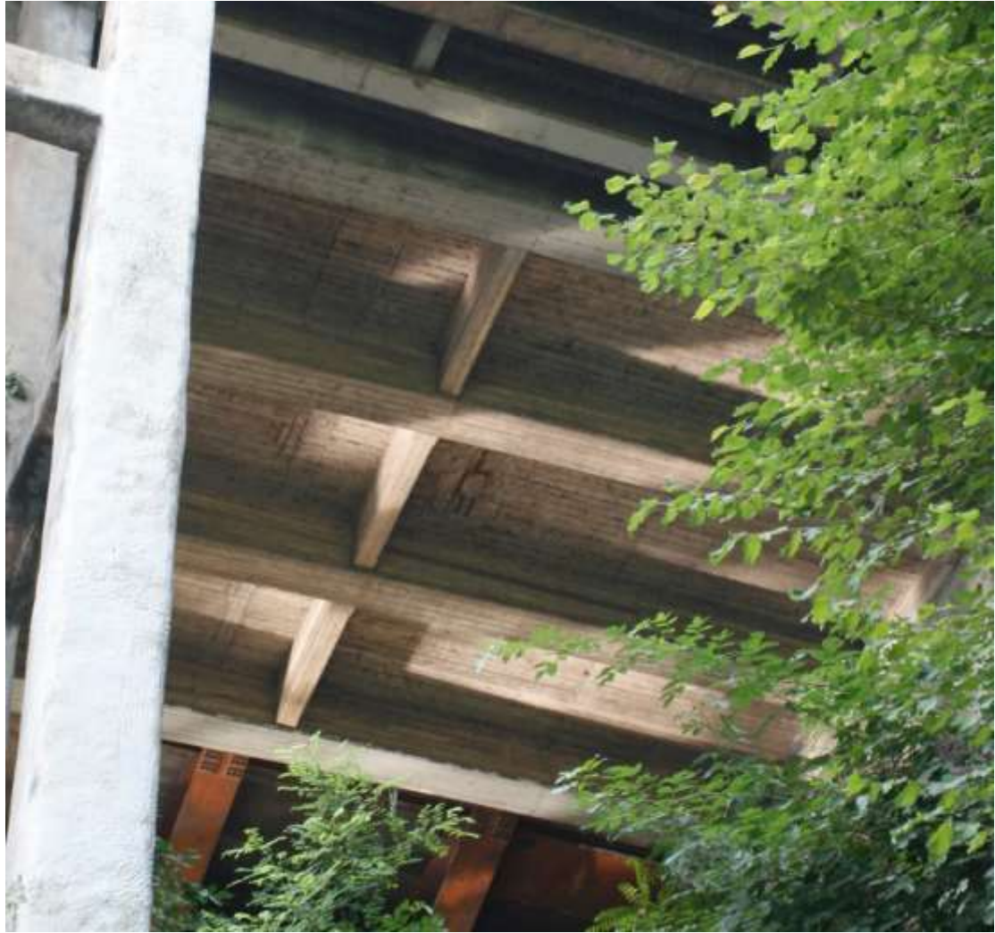
orditura dell'impalcato di appoggio lato Milano, realizzato con calcestruzzo gettato in opera
