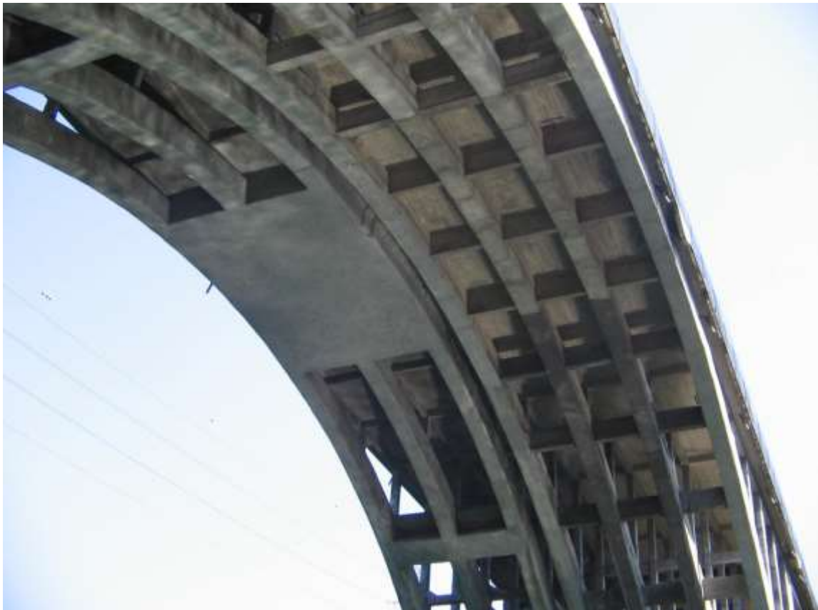
dettaglio zona di chiave delle arcate 1966 (dx), differente da quella del 1927 (sx)
