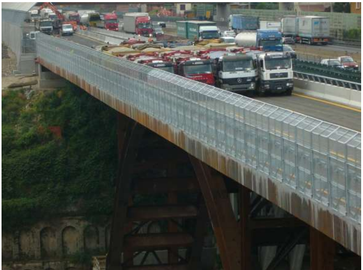
Segnaletica e collaudo con relative prove di carico
