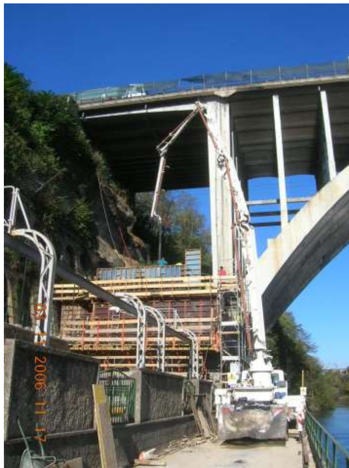
Getto con pompa dei calcestruzzi della fondazione arco lato Milano
