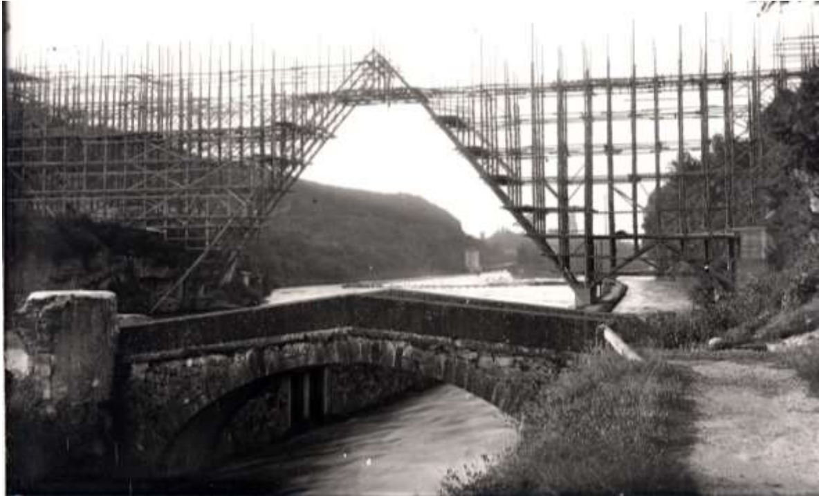
completamento dell'armatura provvisoria vista da monte
