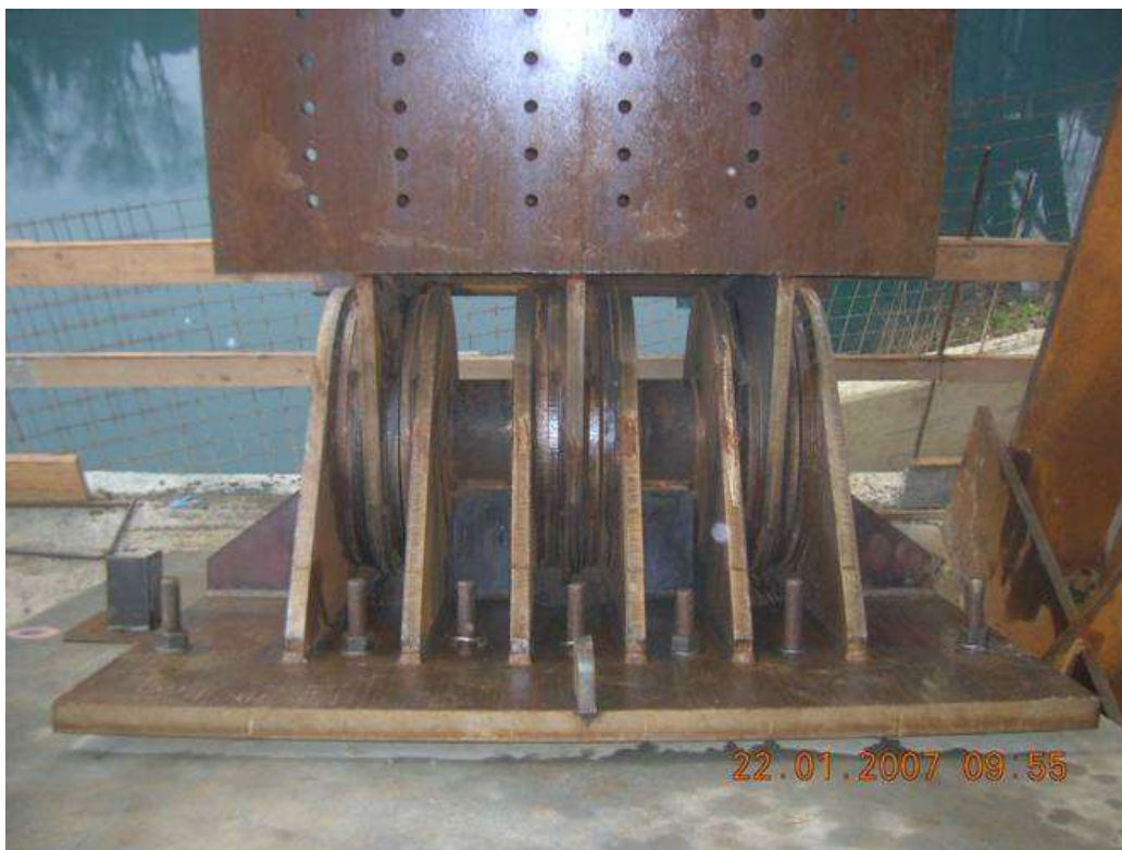
Dettaglio cerniera al piede degli archi
