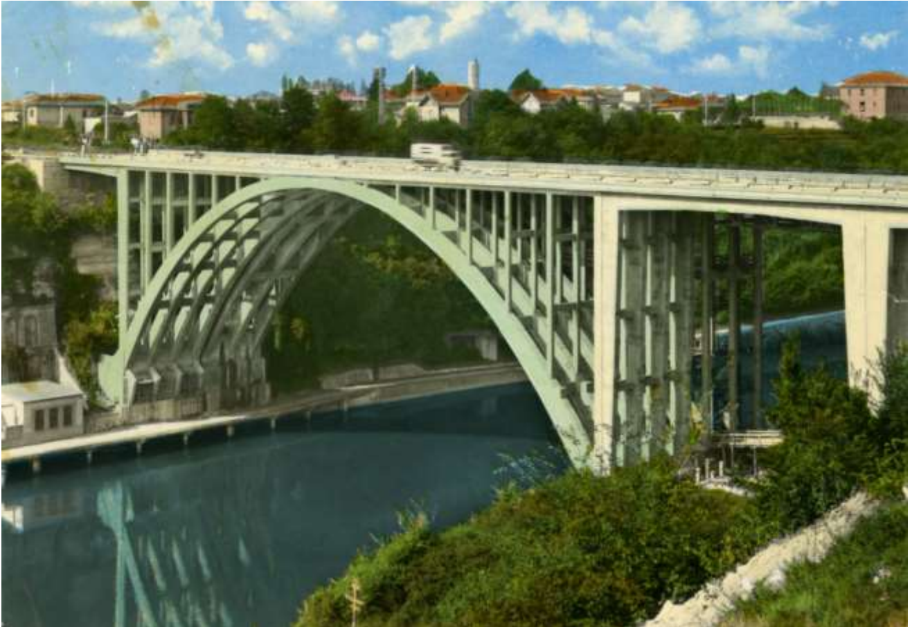
vista generale dell'opera dopo l'apertura al traffico negli anni '60
