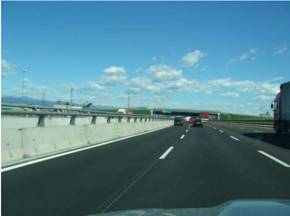
Barriera di sicurezza centrale in corrispondenza di opere d'arte
