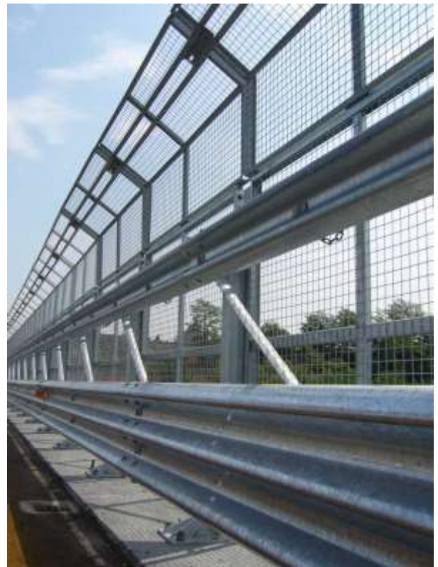
Posa dei giunti e delle barriere bordo ponte
