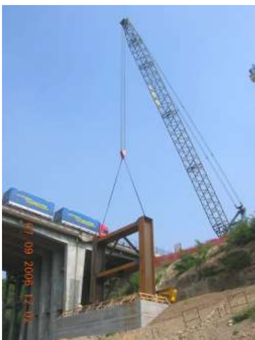
Montaggio pile e travi longitudinali
