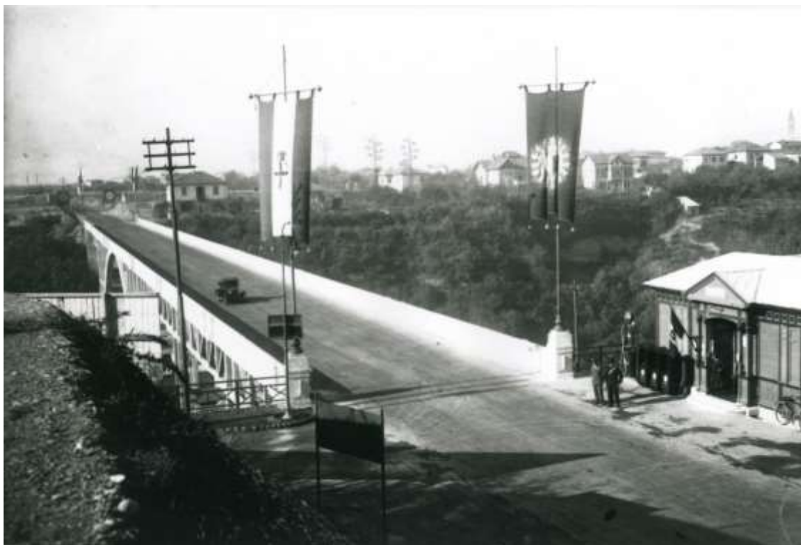
Nuovo ponte sul fiume Adda
