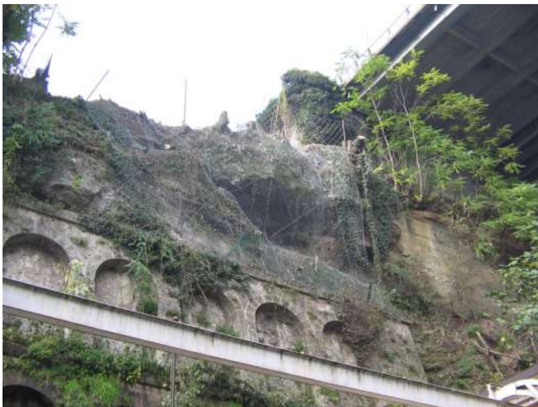
Disboscamento, bonifica ordini bellici, posa reti di protezione e paramassi spalla Lato Milano
