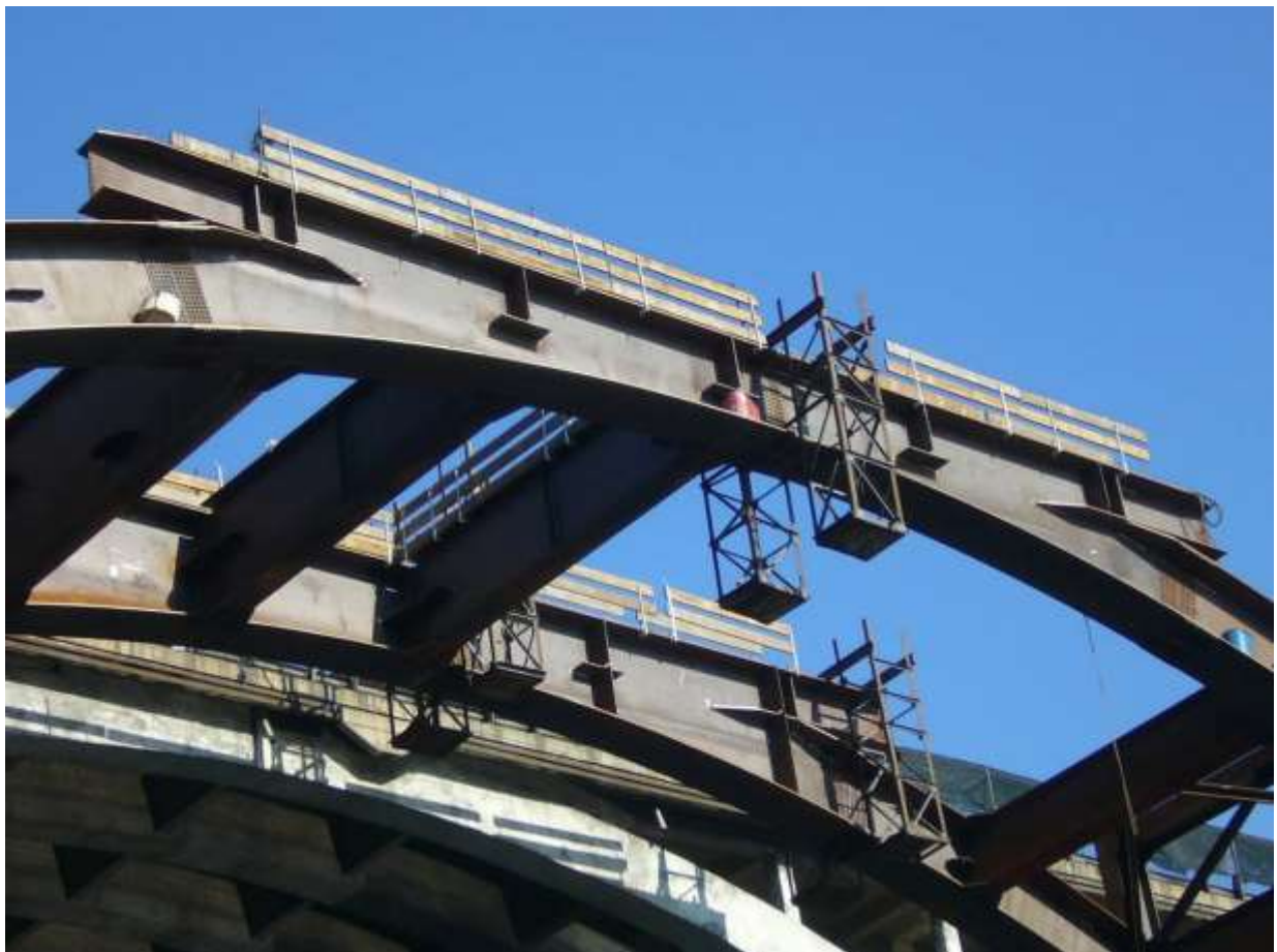
Montaggio elementi della zona in chiave degli archi
