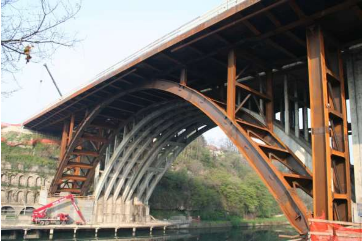
Montaggio struttura completo
