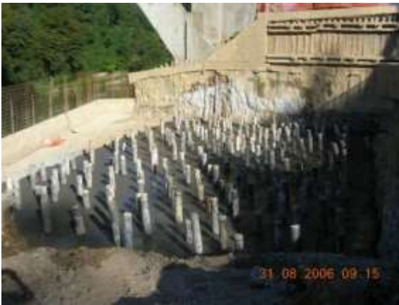
Realizzazione di micropali sotto le fondazioni
