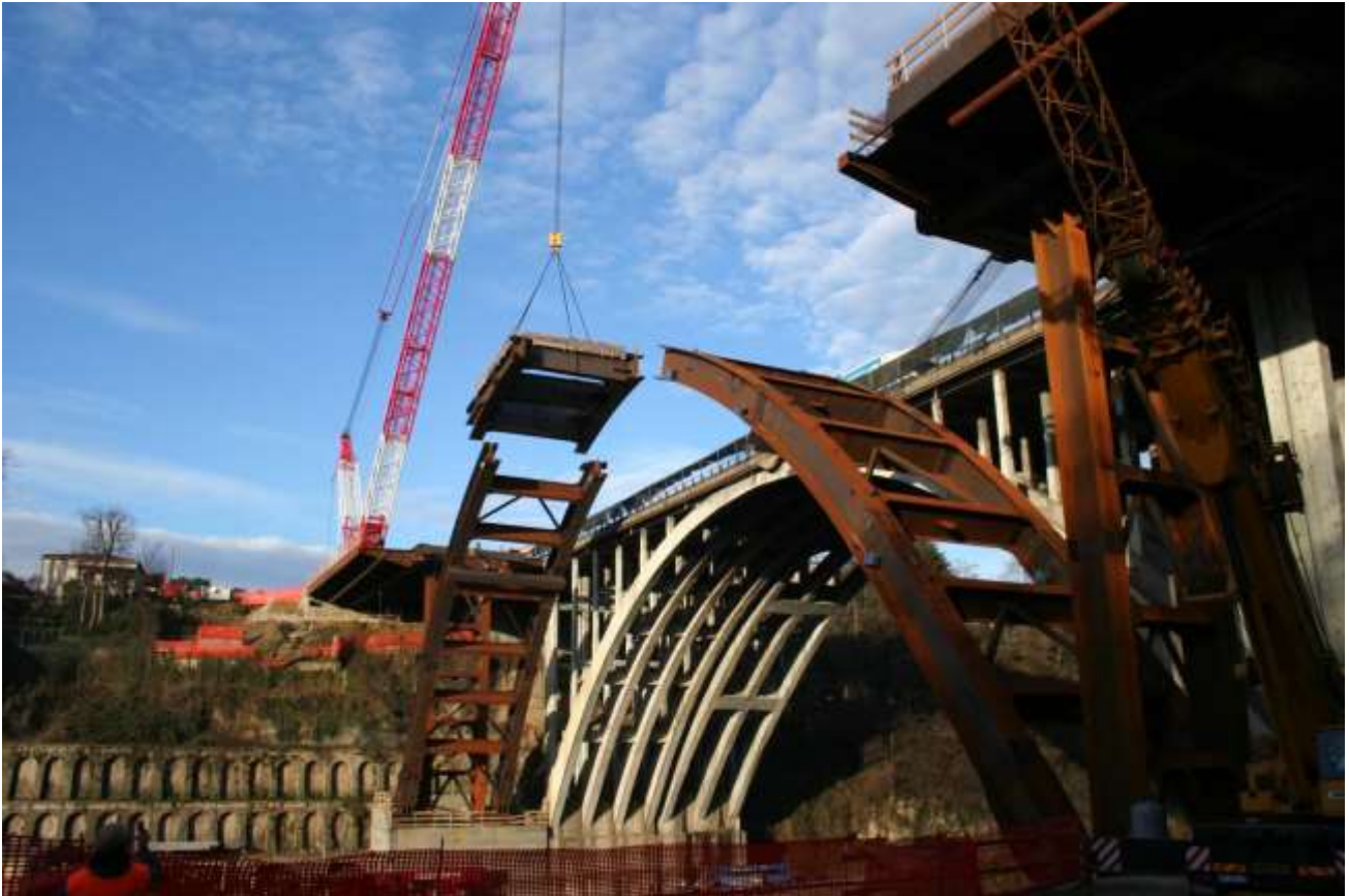
Sollevamento e posa delle zone di chiave pre assemblate
