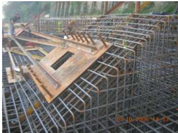
Ferro di rinforzo e posa tirafondi per ancoraggio strutture archi
