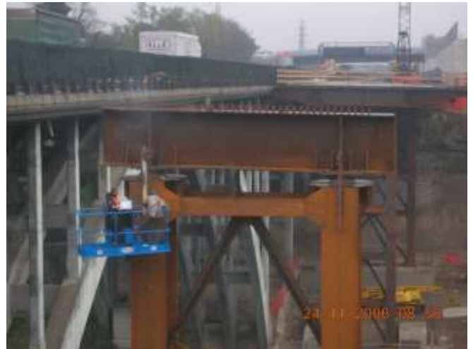
Montaggio pile e traversi campate di appoggio zona arco
