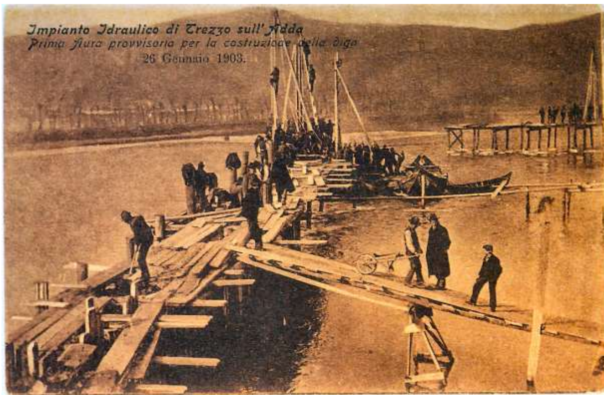
Primi lavori per la costruzione della diga di sbarramento.
