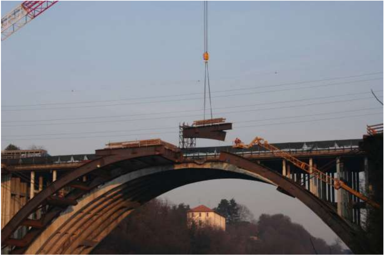
Montaggio elementi della zona in chiave degli archi
