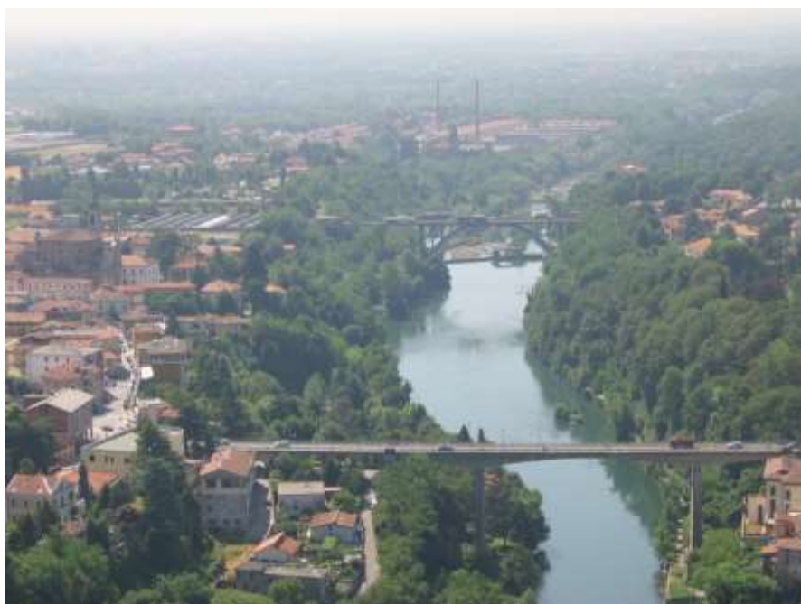
Ponte sulla provinciale che attraversa l'Adda a Trezzo visto da nord
