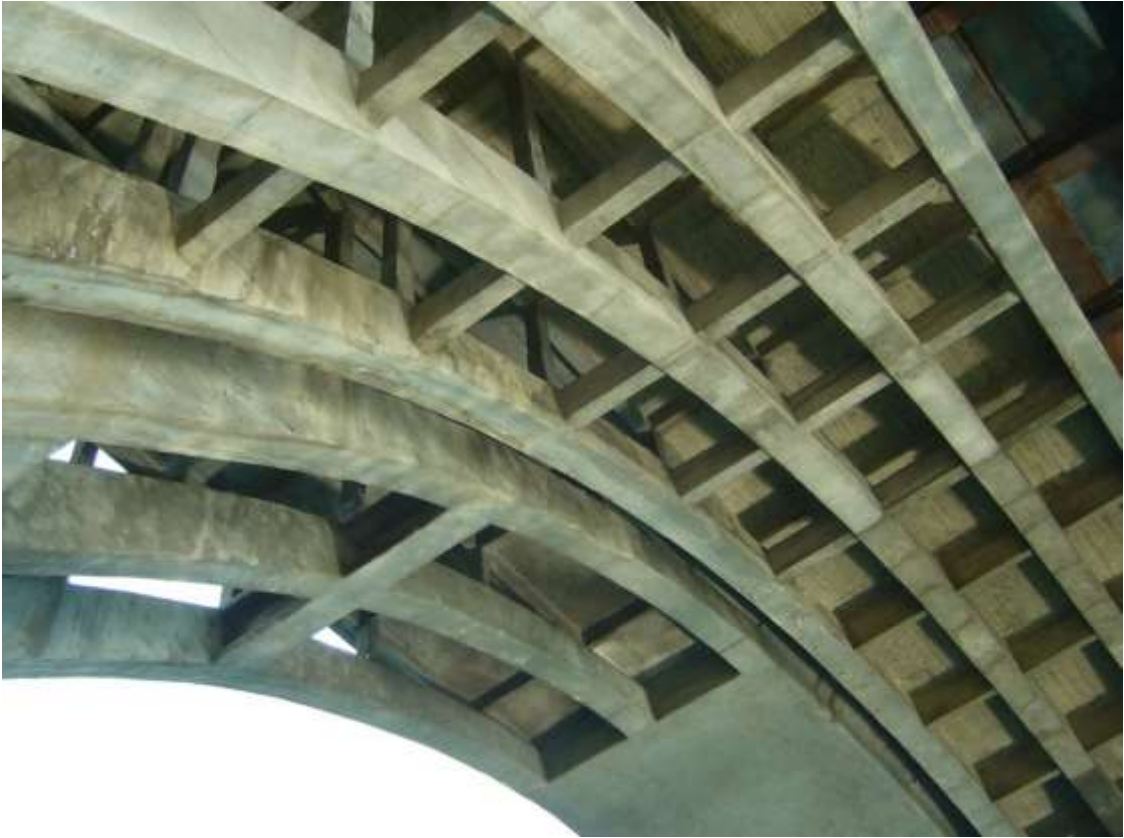
traversi degli archi e pilastri soprastanti (ponte 1966 a dx)
