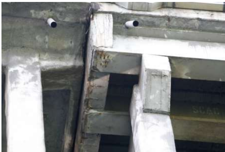
Campate di accesso lato Bergamo rifatte con travi prefabbricate. Dettaglio nuovo traverso su cui appoggiano le travi prefabbricate. Moncherino aggiunto a sbalzo dalle colonne delle pile per appoggiare travi di bordo.
