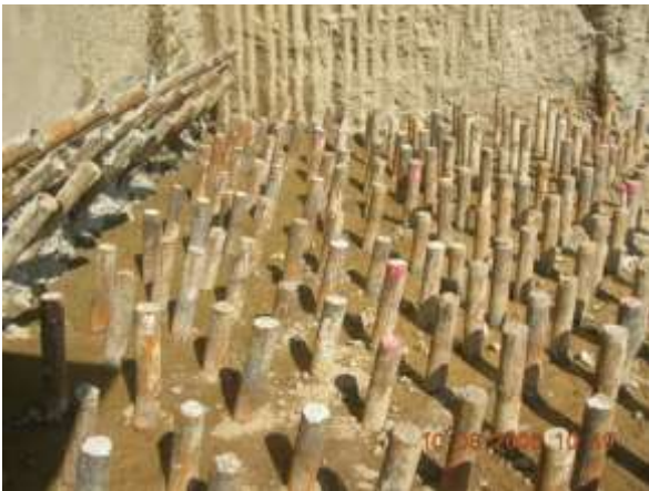
Realizzazione di micropali sotto le fondazioni
