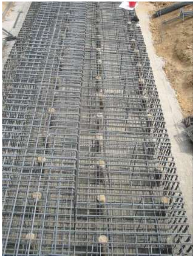
Magroni di sottofondazione ed armatura in ferro
