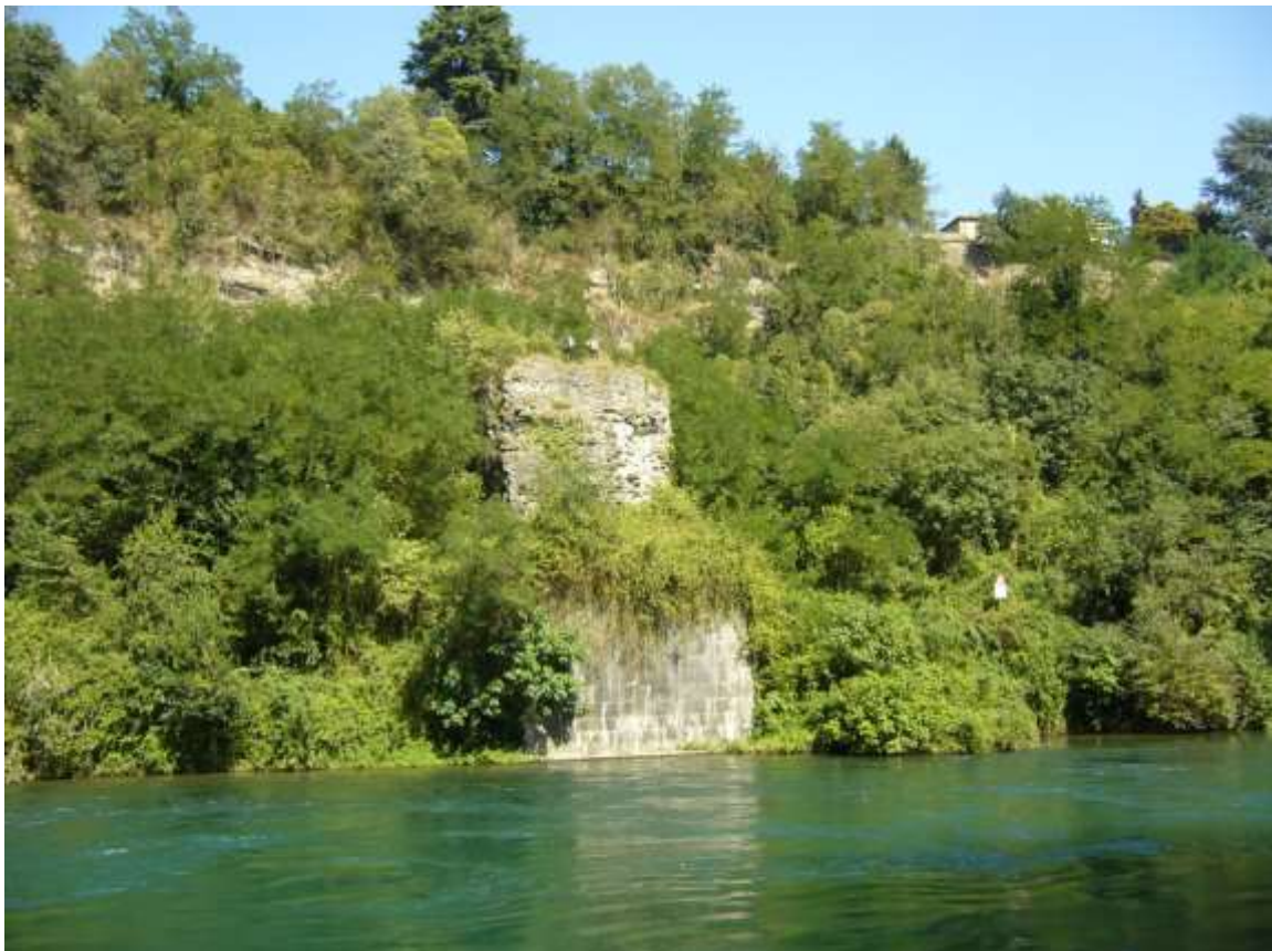
Dettaglio ravvicinato della struttura che è rimasta in Est alla data odierna
