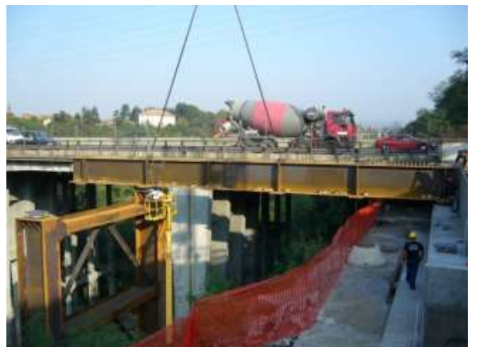
Montaggio pile e travi longitudinali
