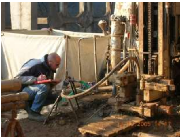
Indagini geognostiche aree fondazioni per verificare condizioni sottosuolo
