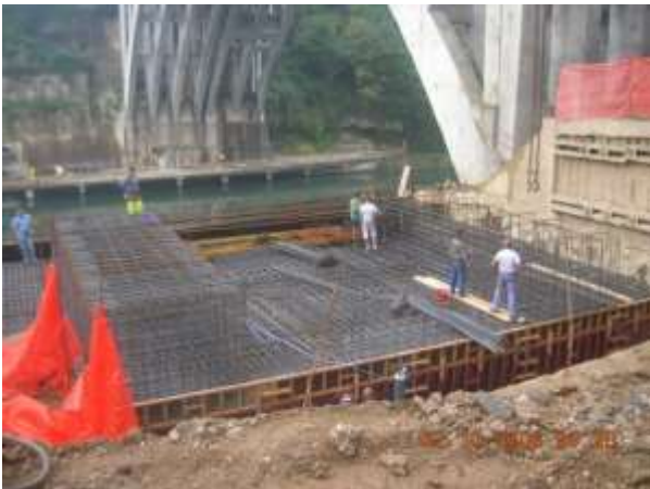
Armatura in ferro di alcune fondazioni
