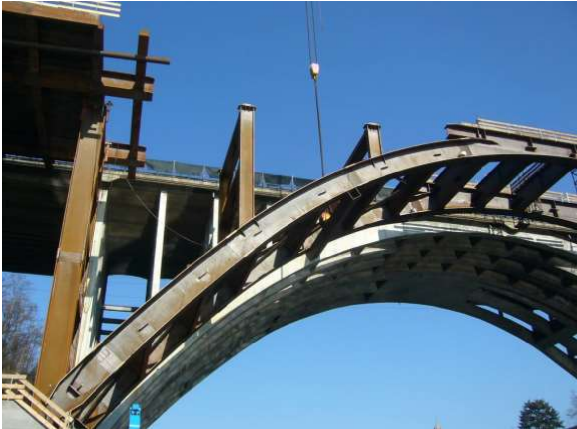
Montaggio delle pile rimanenti che si intestano sull'arco, travi e posa predalles con travi tipo pittini
