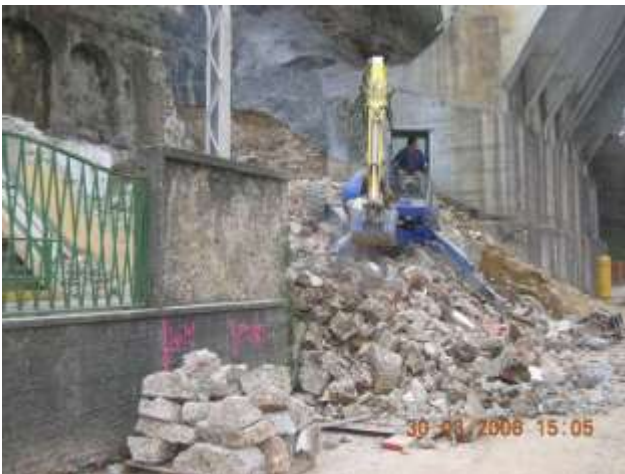
Demolizione edificio Italgas e scavi per la realizzazione delle fondazioni
