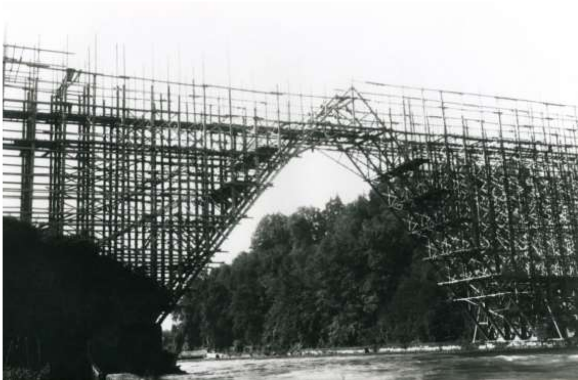
congiungimento dell’armatura provvisoria al vertice
