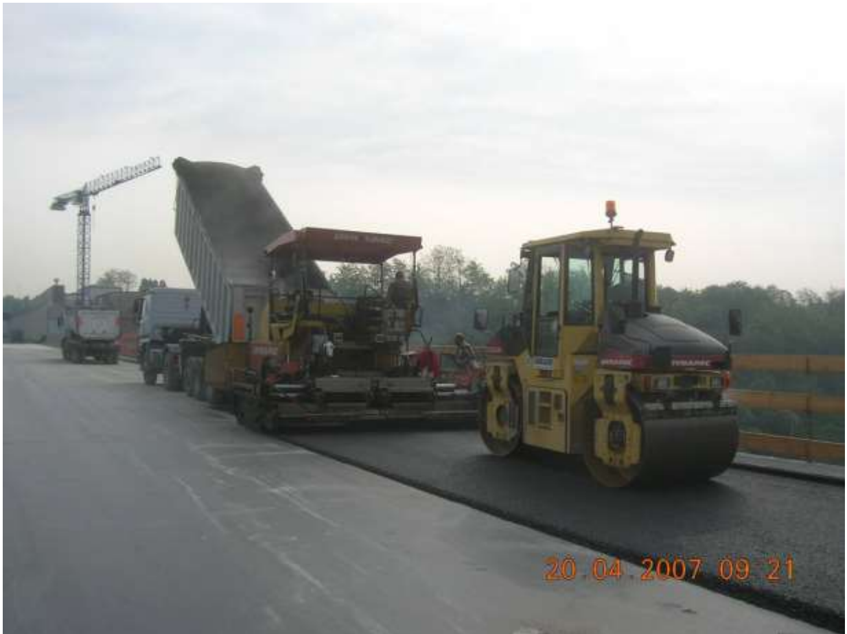
Esecuzione degli asfalti sopra l'impalcato
