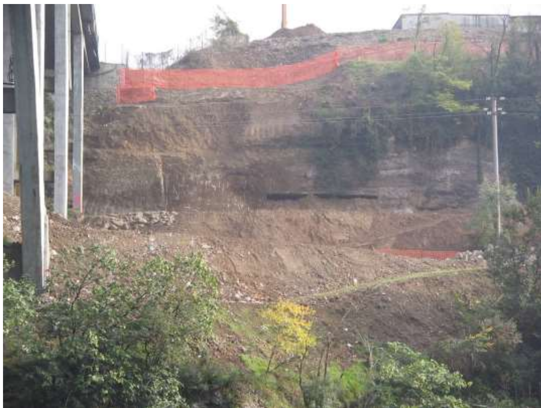
Scavi in spalla sinistra lato Bergamo
