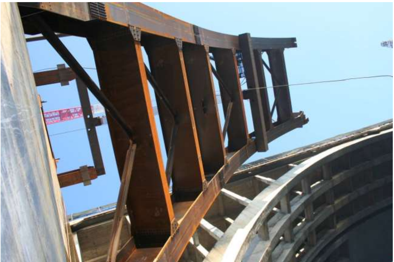
Dettaglio montaggio arco lato Milano. Notasi accesso alle zone di lavoro con piattaforma idraulica
