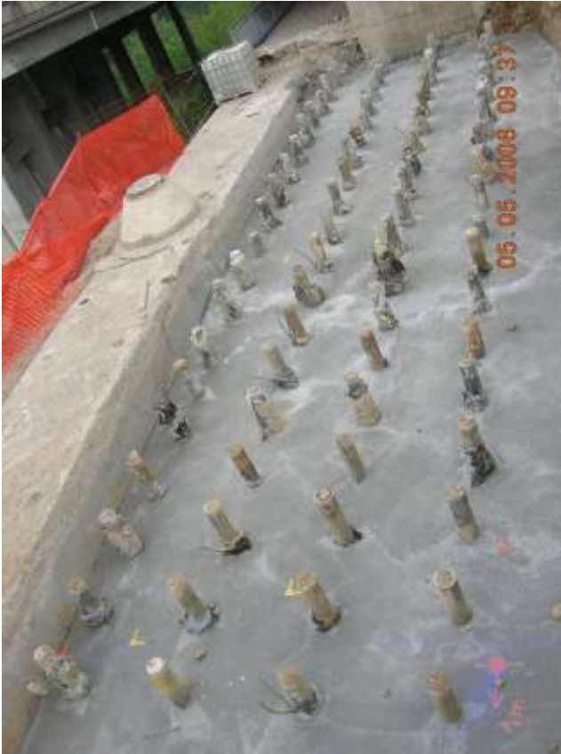
Magroni di sottofondazione ed armatura in ferro
