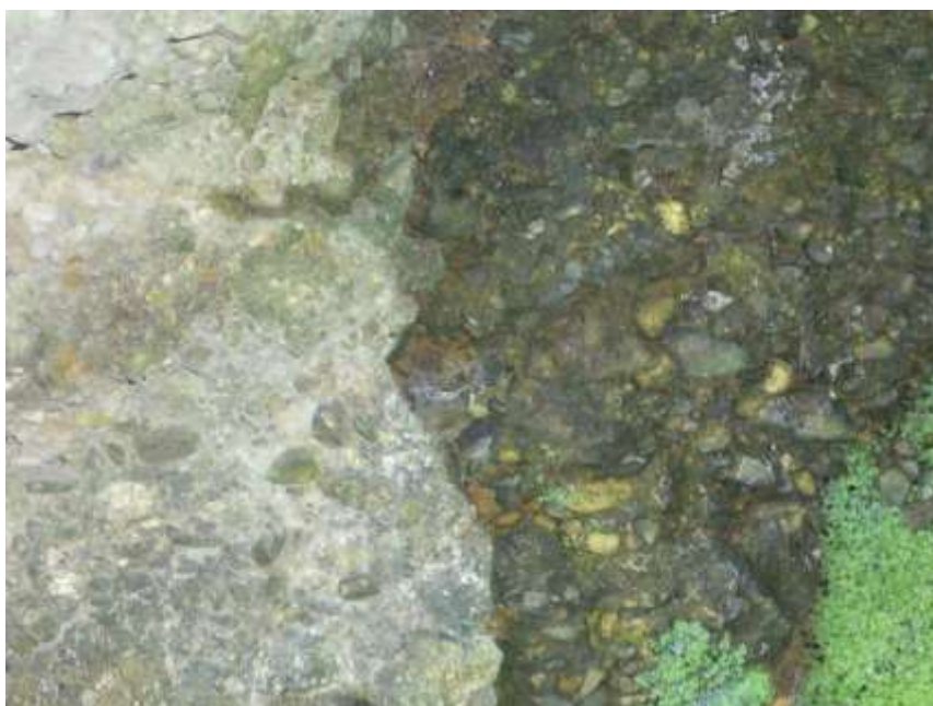
dettaglio della superficie di accostamento tra calcestruzzo (sinistra) e ceppo (destra)
