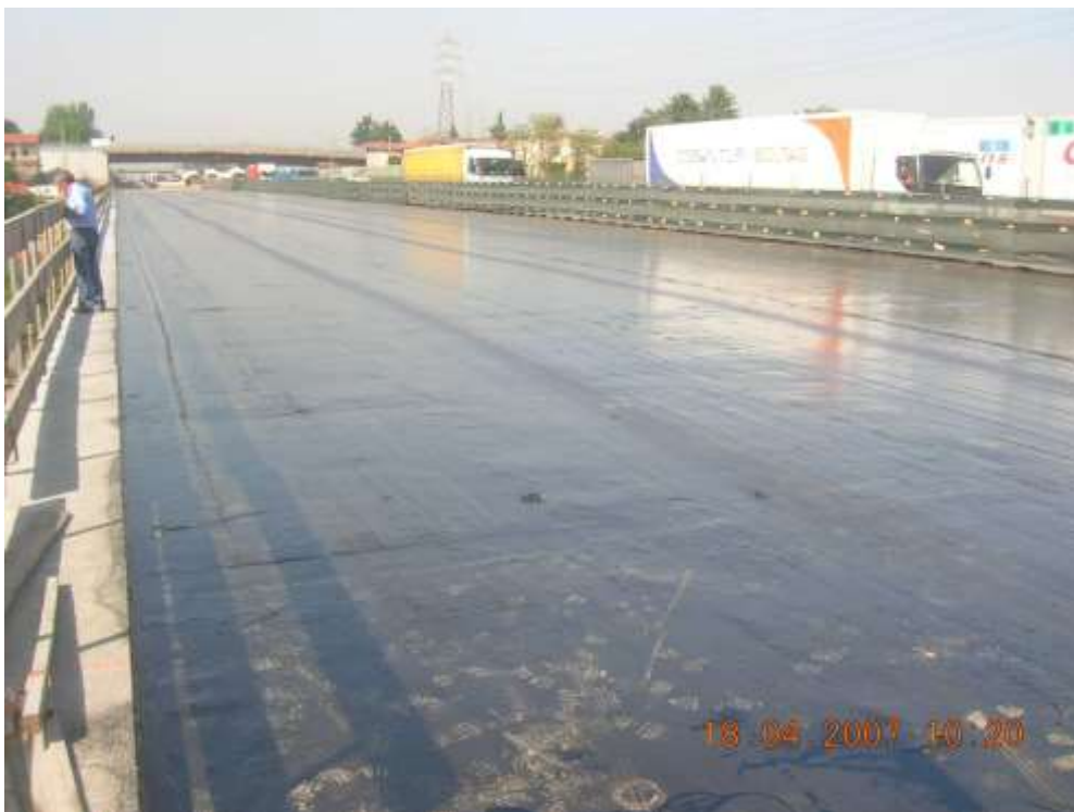
Posa della guaina impermeabilizzante
