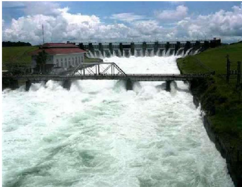
Il Lago artificiale di Miraflores è stato ottenuto sbarrando il fiume Cocoli che attraversa il canale in modo ortogonale.
