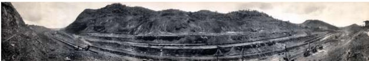
La roccia veniva forata con macchine ad aria compressa che producevano fori da 4" e 6" lunghi da 4 a 10 metri con una maglia variabile da 1.80 a 4.50 metri.
