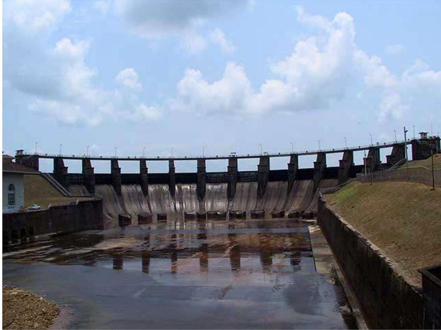
Lo sfioratore è stato realizzato in calcestruzzo con lo sfioro a quota 21 metri. Il profilo planimetrico curvo dello sfioratore è lungo circa 225 metri ed è in grado di portare piene dell'ordine di 3920 mc./sec. scaricando nel vecchio letto del fiume Chagres attraverso 14 luci, separate da pile che sostengono la strada
